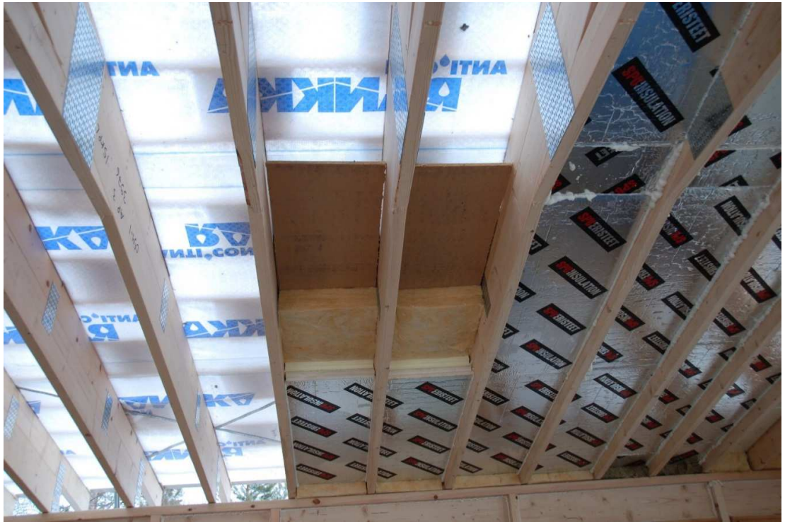
Kuva 12 Katon rakenne (asiakkaan ottama kuva)
