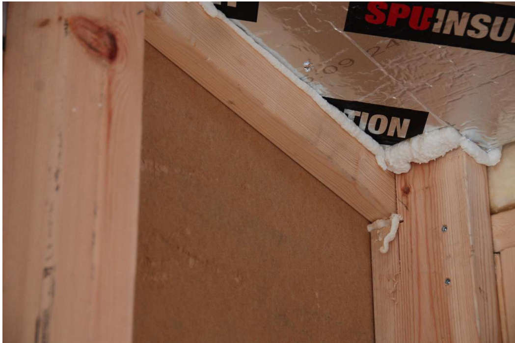
Kuva 9 Tuulensuojalevyn asennus (asiakkaan ottama kuva)
