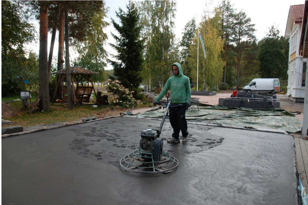
Kuva 7 Helikopterin käyttö (asiakkaan ottama kuva)
