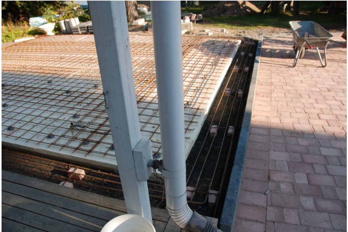
Kuva 6. Raudoitus (asiakkaan ottama kuva)
