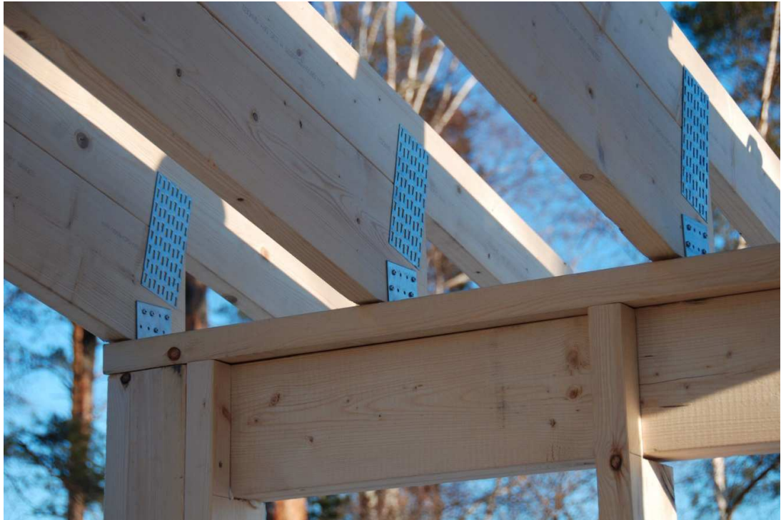
Kuva 10 Kattotuolin kiinnitys (asiakkaan ottama kuva)
