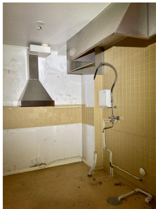
KUVA 54. Maantasokerroksessa sijainneen jakelukeittiön nykytila (Roosa Hiltunen 2024).
