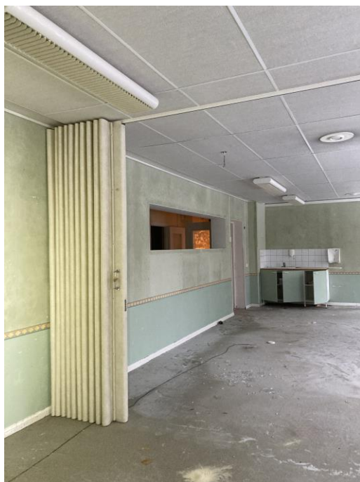
KUVA 58. Entinen yhden kotityhmän leikki- ja lepoaunne rakennuksen eteläpuolella (Roosa Hiltunen 2024).
