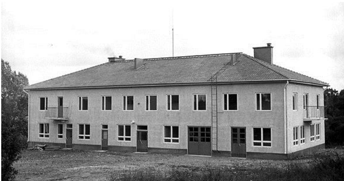
KUVA 14. Vuonna 1957 valmistunut koulurakennus, Åbolands Manliga Hems-löjdskola (Ingmar Hagman 1957).
