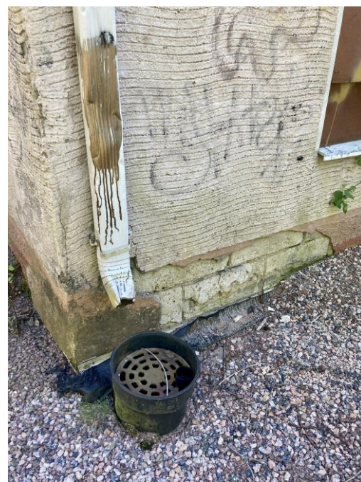
Kuva 32. Luoteiskulmassa pintarappauksen alta paljastuneet ulkoseinän kevytbetoniarkot (Roosa Hiltunen 2024).
