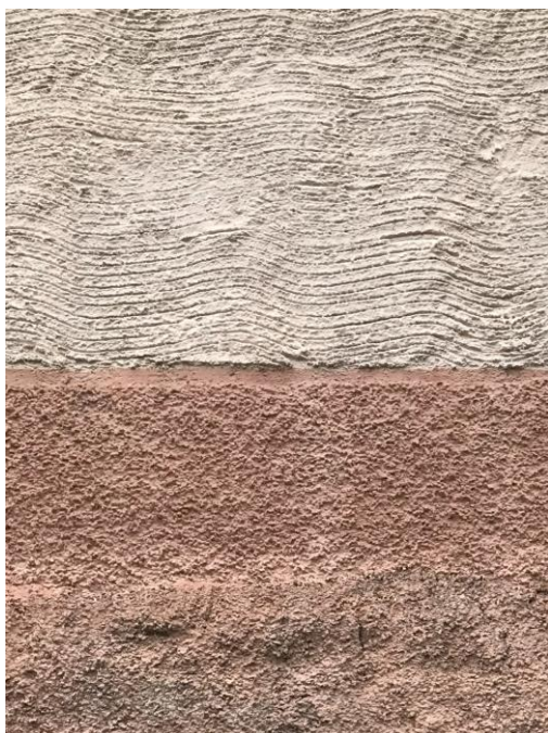
KUVA 29. Julkisivujen roiskerappaus sokkelissa ja ulkoseinissä (Roosa Hiltunen 2024).
