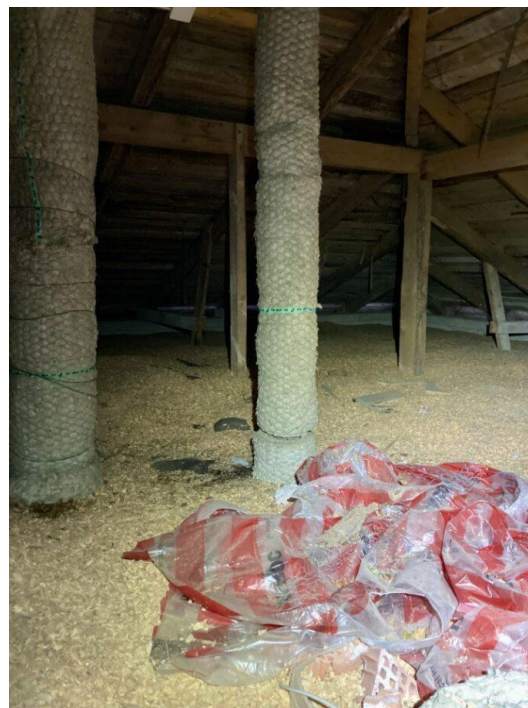
KUVA 64. Laajennusosan ullakko ja puhallusvilla (Roosa Hiltunen 2024).
