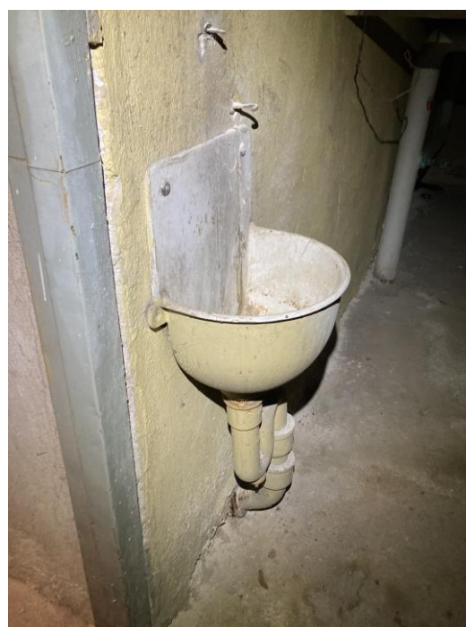
KUVA 46. Alkuperäinen seinäkiinnitteinen käsienpesuallas keltaiseksi maalatulla seinällä (Roosa Hiltunen 2024).
