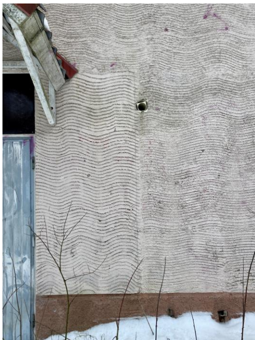
KUVA 38. Pohjoisjulkisivusta poistetun oviaukon saumakohta (Roosa Hiltunen 2024).
