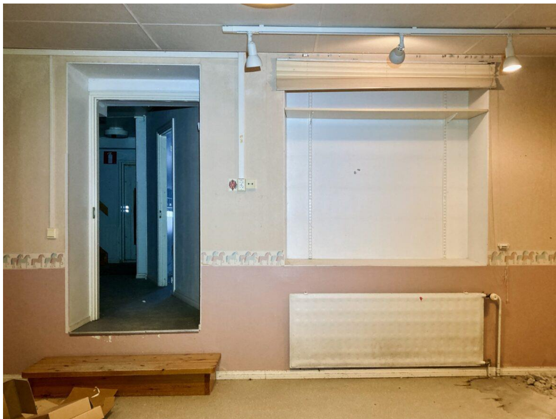
KUVA 55. Oviaukko ja entinen ikkuna-aukko alkuperäisrakennuksen ja laajennusosan liitoskohdassa (Roosa Hiltunen 2024).
