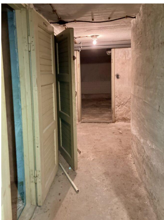
KUVA 45. Alkuperäisrakennuksen kellarin käytävä, jonka vasemmalla puolella entisiä perunakellareita (Roosa Hiltunen 2024).
