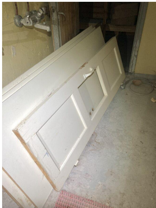
KUVA 48. Väliovia alkuperäisrakennuksen kellarin entisessä pesuhuoneessa (Roosa Hiltunen 2024).
