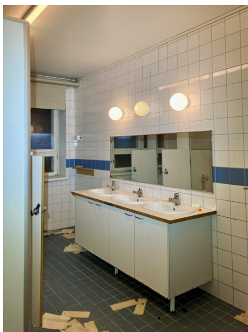
KUVA 56. Maantasokerroksen pesuhuone (Roosa Hiltunen 2024).
