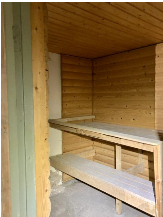
KUVA 47. Alkuperäisrakennuksen kellarin entinen sauna (Roosa Hiltunen 2024).
