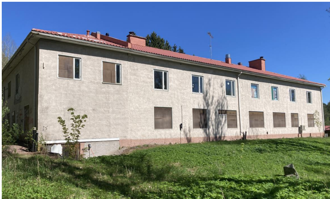
KUVA 35. Eteläjulkisivun ikkuna-aukotusta (Roosa Hiltunen 2024).
