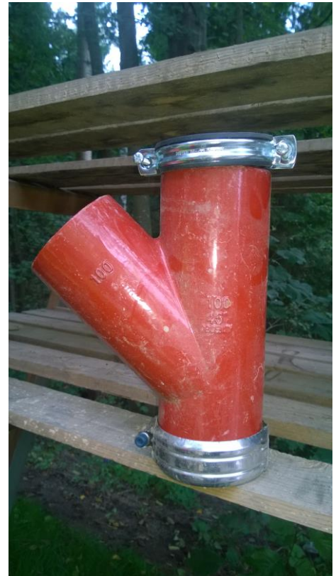
Kuva 41. Työmaalla pystyviemärin ja lattiakaivon haara kiinnityspantoinen.
