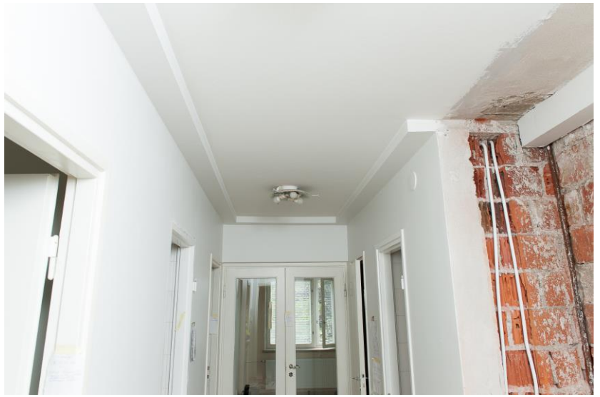
Kuva 38. Eteisen valmis kotelointi [36]
