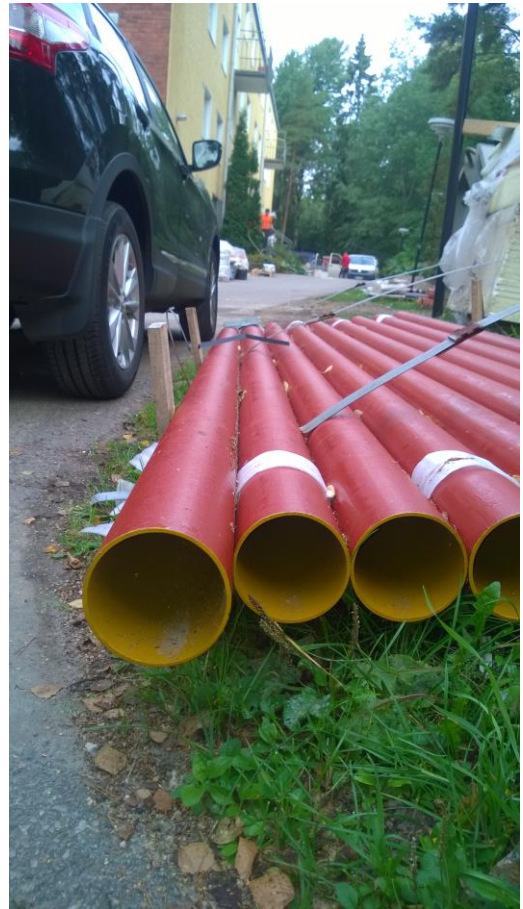
Kuva 42. Työmaalle varastoidut epoksipintaiset valurautaviemäriputket.
