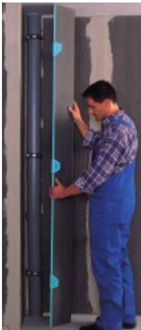
Kuva 29. Wedi-kotelon asennus [27 s. 7]
