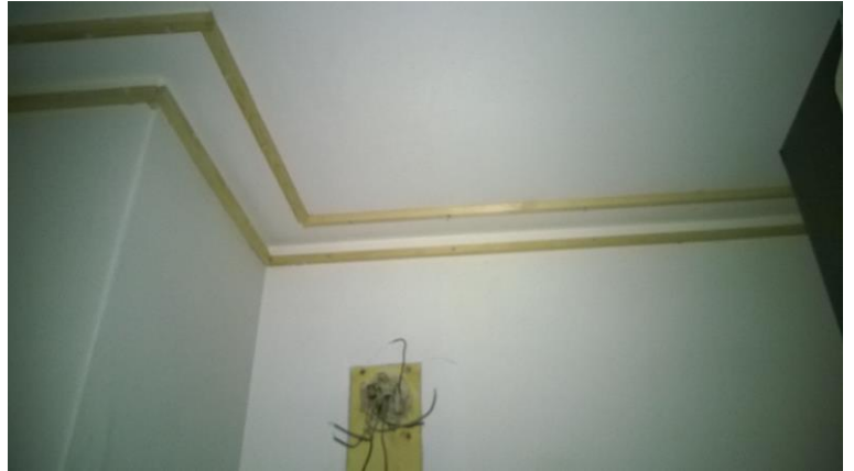
Kuva 34. Huoneiston purettu sähkökeskus [35]
