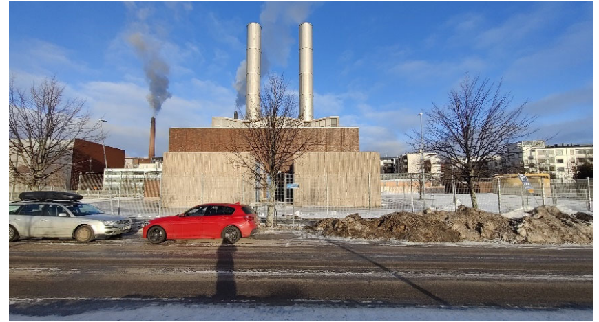
Kuva 10. Näkymä pohjoiseen, Kellosaaren varavoimalaitos.
