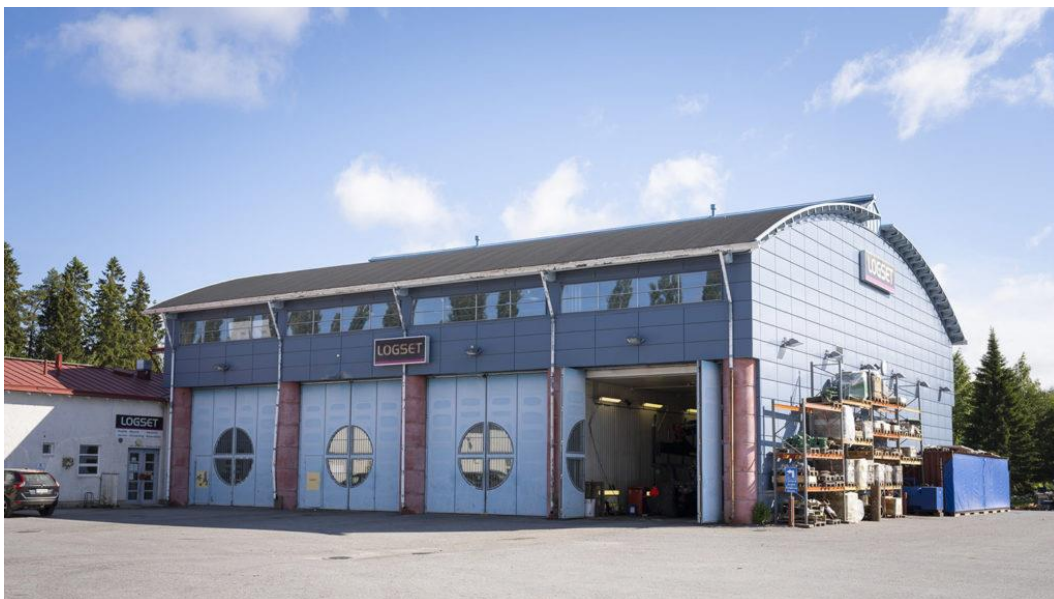
Kuva 1. Logset Varaosa- ja huoltokeskus. Kuva : https://logset.fi/huolto/
