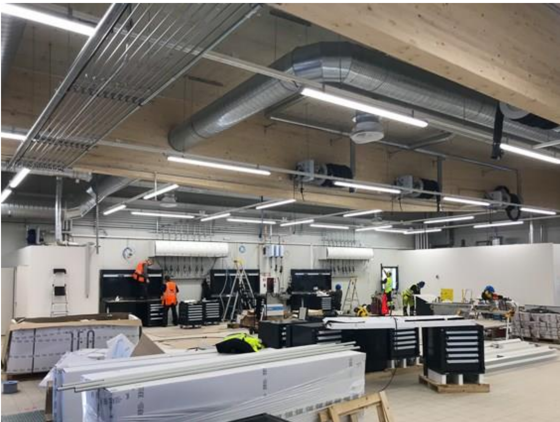
KUVA 5. Huoltotilojen rakentaminen asiakkaalle
