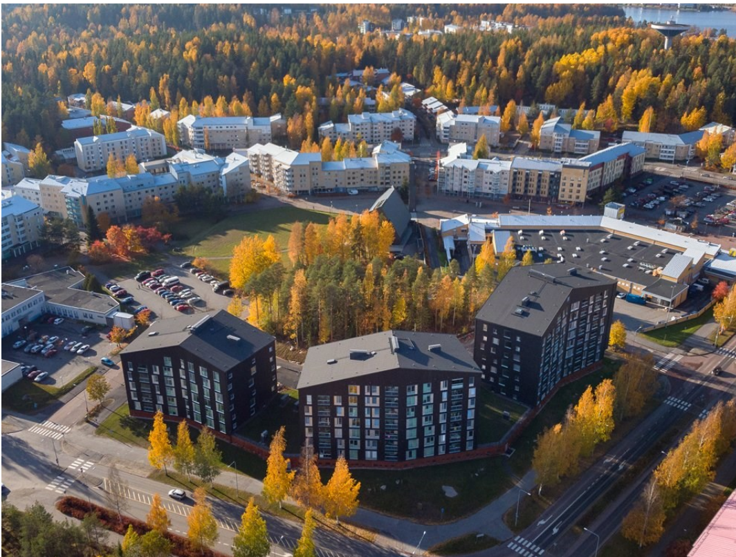
Kuva 1. Kuvan etualalla Puukuokka-kerrostalokortteli valmistuneena 2018. (Puuinfo, 2018)
