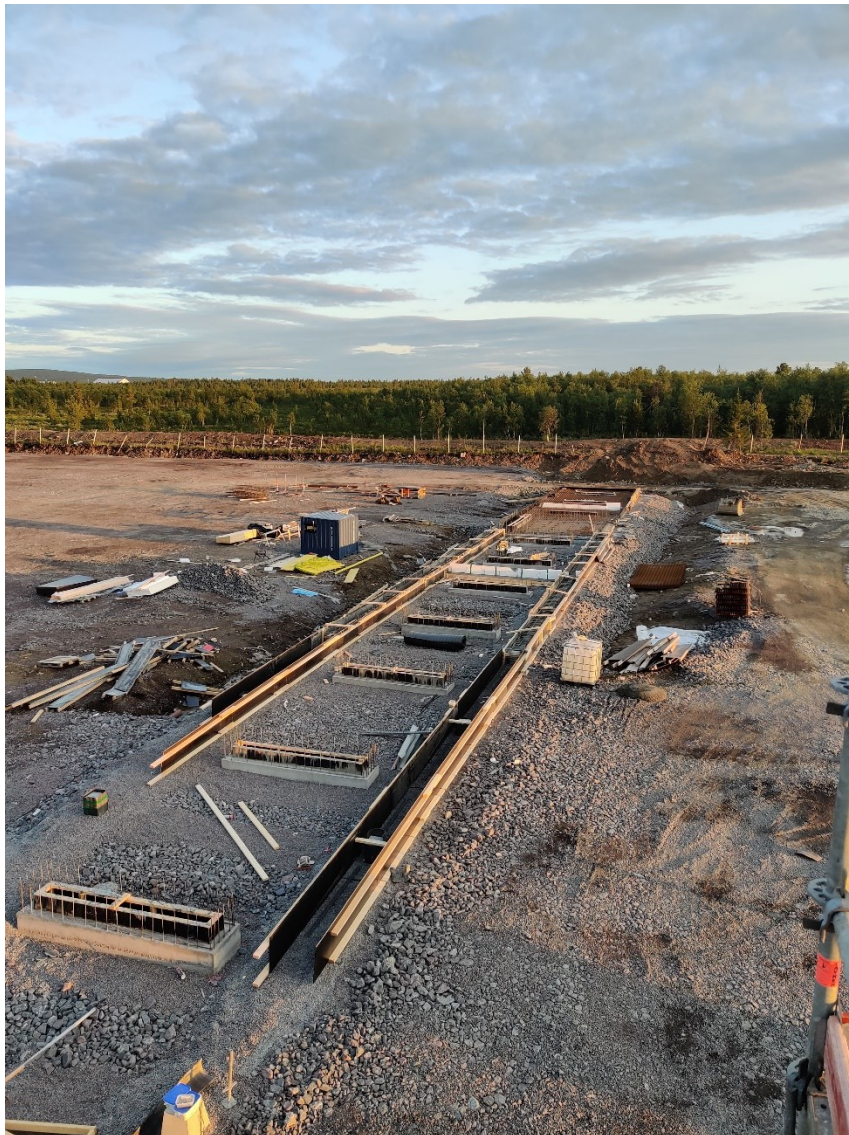
Kuvio 2. Katoksen reunapalkki ja lattia raudoitusvaiheessa
