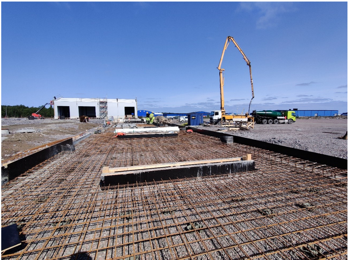
Kuvio 3. Raudoitettua katoksen lattiaa
