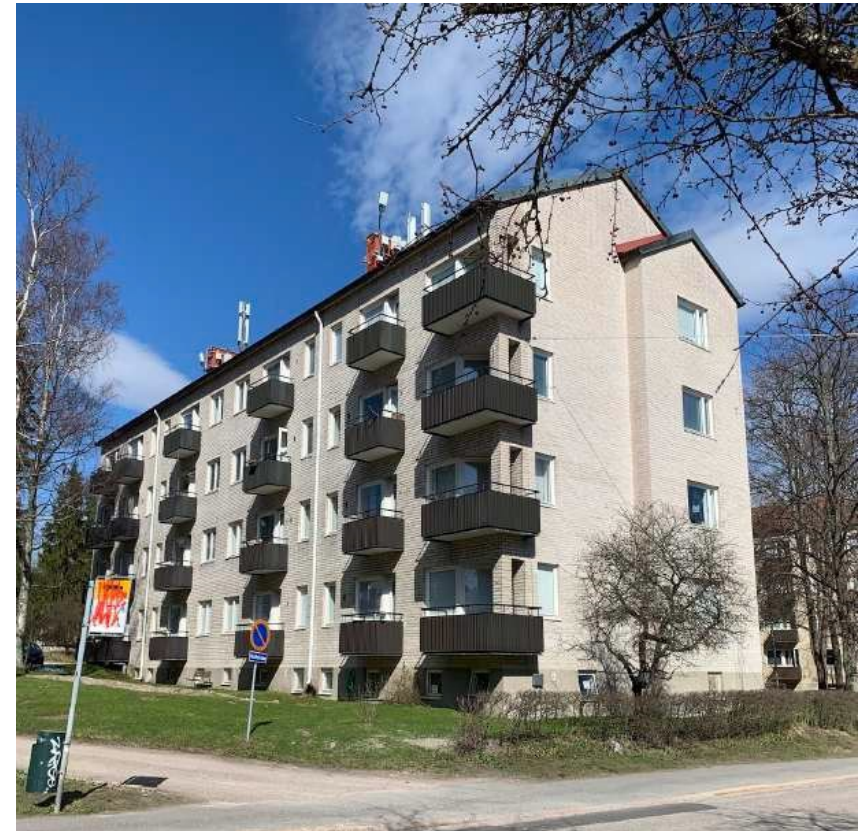
Kuva 10. Tonttia vastapäätä vuonna 1951 valmistunut Isokaari 15 asuinkerrostalo. Tyypillisenä rakennuksessa ulkonevat parvekkeet, tiilijulkisivu sekä aukotukset. Parvekkeet erottuvat selkeästi vaaleasta julkisivusta. Pintaa ei ole myöskään rapattu.
