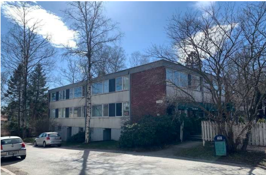
Kuva 5. Tontilla sijaitseva olemassa oleva rakennus Isokaaren ja Takaniementien risteyksestä katsottuna.
