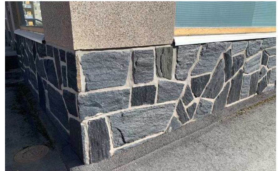
Kuva 29. Julkisivussa tumma liuskekivilaatta vaihtuu rappauspintaan noin puolenmetrin korkeudella maanpinnasta.
