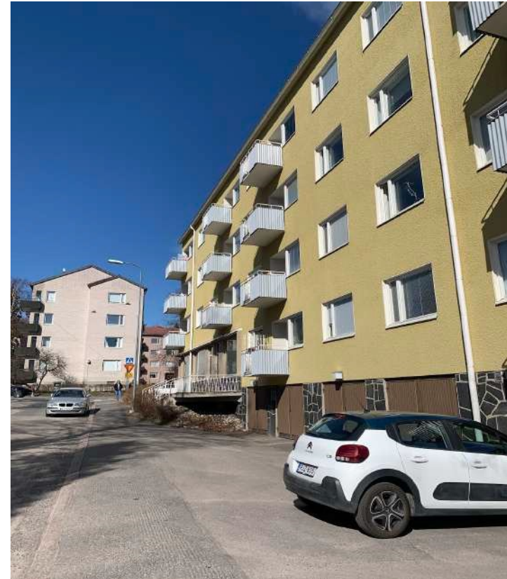
Kuva 12. Isokaari 22 asuinrakennuksen pitkäjulkisivu takaniementieltä päin.
