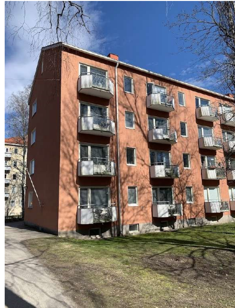
Kuva 14. Isokaari 12 asuinrakennuksen pitkäjulkisivu Isokaareltä päin.
