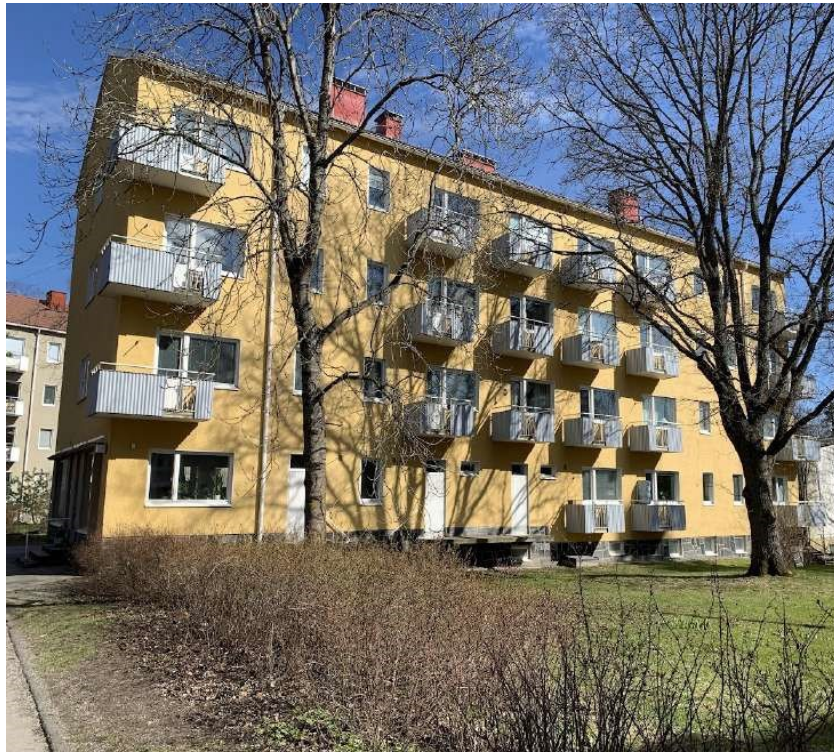
Kuva 13. Isokaari 18 asuinrakennuksen pitkäjulkisivu Isokaareltä päin.
