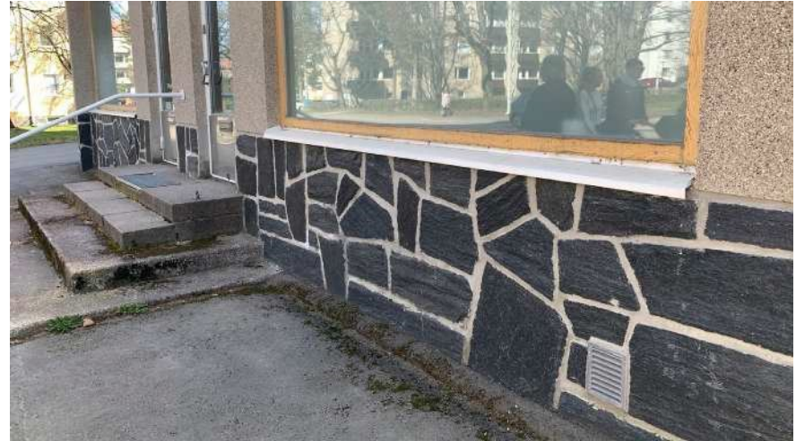
Kuva 28. Isokaari 22 kadunpuoleinen pääty ja liiketilan suuret ikkunat. Rakennuksen jalusta erottuu julkisivusta värein ja materiaalein.
