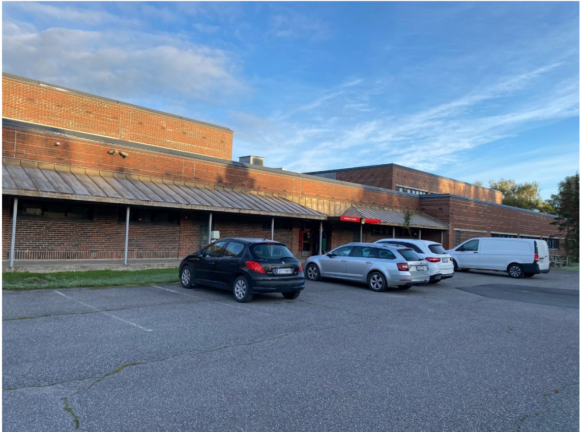
Kuva 4. Peltolan koulutalon C-rakennus.
