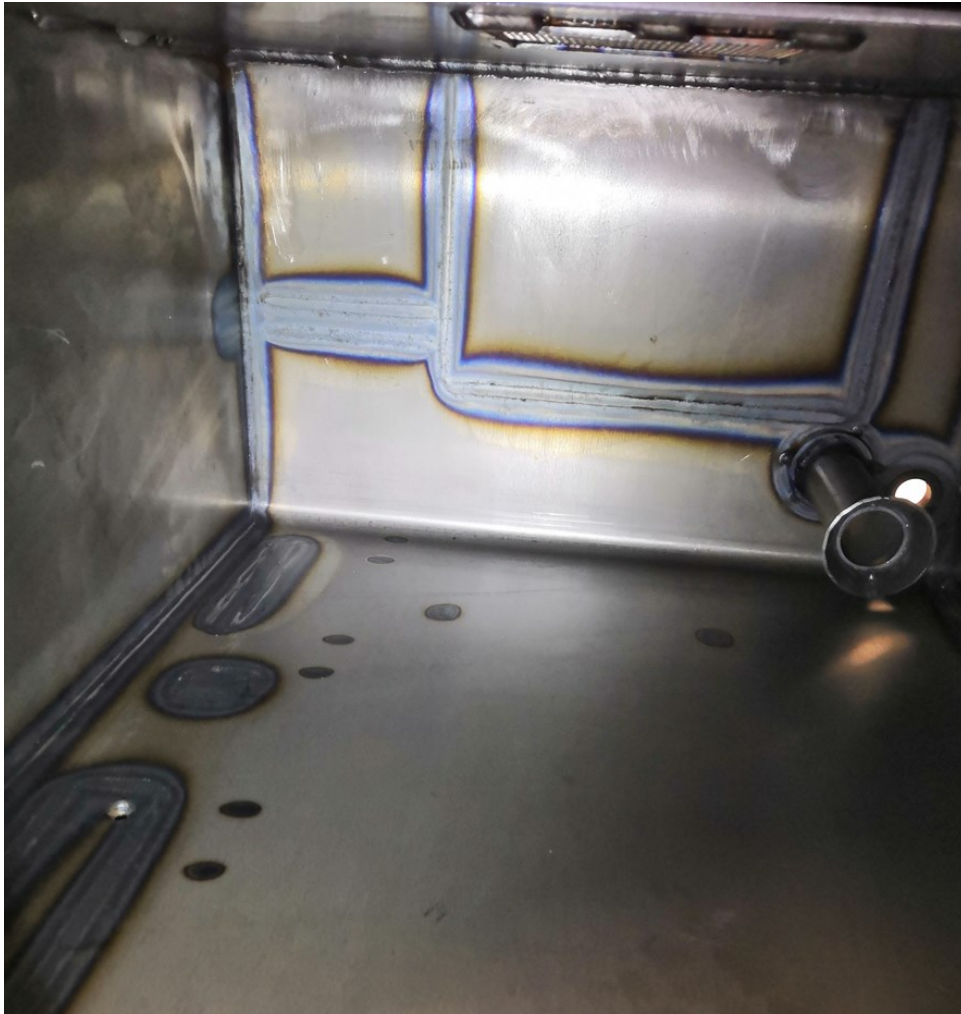
Kuva 6. Ulkopuolen hitsisaumat, jotka muodostavat sisäseinämään hilsettä. (Kuva: Veli-Ville Korpela).
