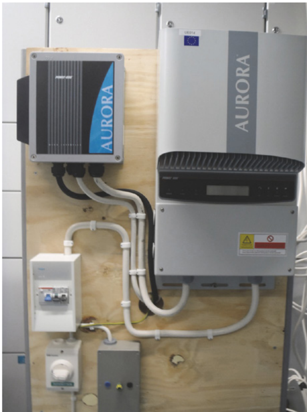
Kuva 25. Tuule E200 4 kW tuulivoimalan sähkötekniisten ohjaus- ja liitälaitteiden siirrettävä asennusteline (tuulivoimalaa käytetään ja tutkitaan laboratorioympäristössä).
