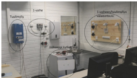
Kuva 7 a) Aurinko ja tuulisähkön asennus- ja käyttöympäristön työt menossa (Joensuu, Tuohino, Veteli 2013, 15)
