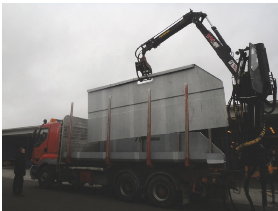
Kuva 4. Opiskelijoiden suunnitteleman ja toteuttaman energiapuurekan lisälaitojen asennus ammattioppilaitoksen pihalla Kemissä.
