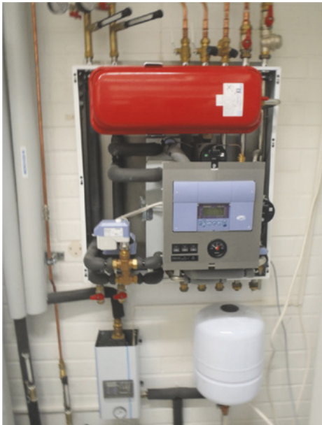
Kuva 16. Pientaloihin soveltuva kaukolämmönvaihdin (kotelo avattuna) ja alapuolella on osa tyhjökeräinjärjestelmän toimintayksiköstä.
