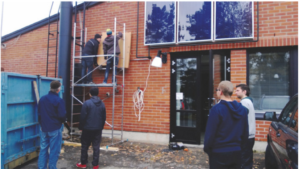
Kuva 3. Aurinkopaneelien asennus seinälle menossa opiskelijoiden projektiryhmän toimesta (huomaa paneelit on suojattu auringon säteilyltä).
