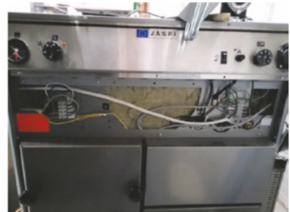
Kuva 7. b) Pellettikattilan sähkökytkennät meneillään (Erkheikki, Kalliosalmi, Kantola 2013, 11)
