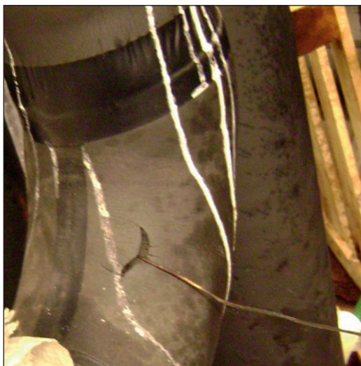
Kuva 16. Anturin asennus eristeen alle.
