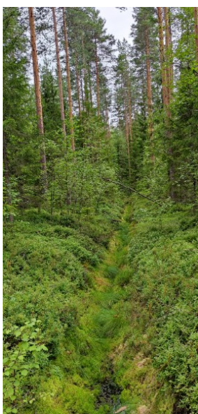
KUVA 4. Ojat ovat umpeutuneet pintakasvillisuudesta ajan saatossa. (Sipola, 2022)
