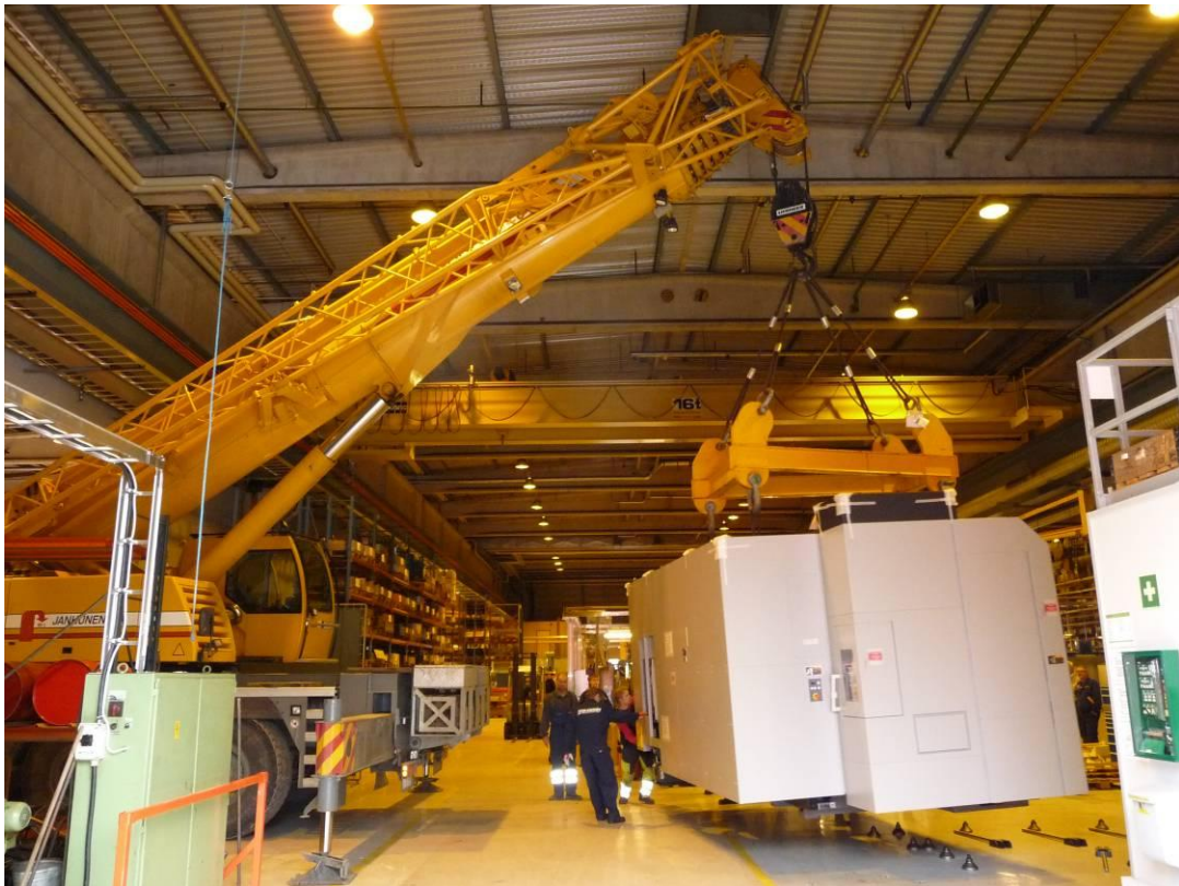
Kuva 19 Sorvauskeskuksen paikalleen asennus
