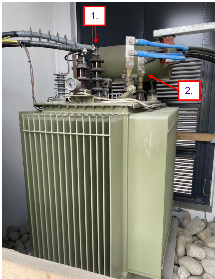
KUVA 6. Ilmalassa sijaitseva yksivaihemuuntaja. 1 ensiöpuoli, 2 toisiopuoli
