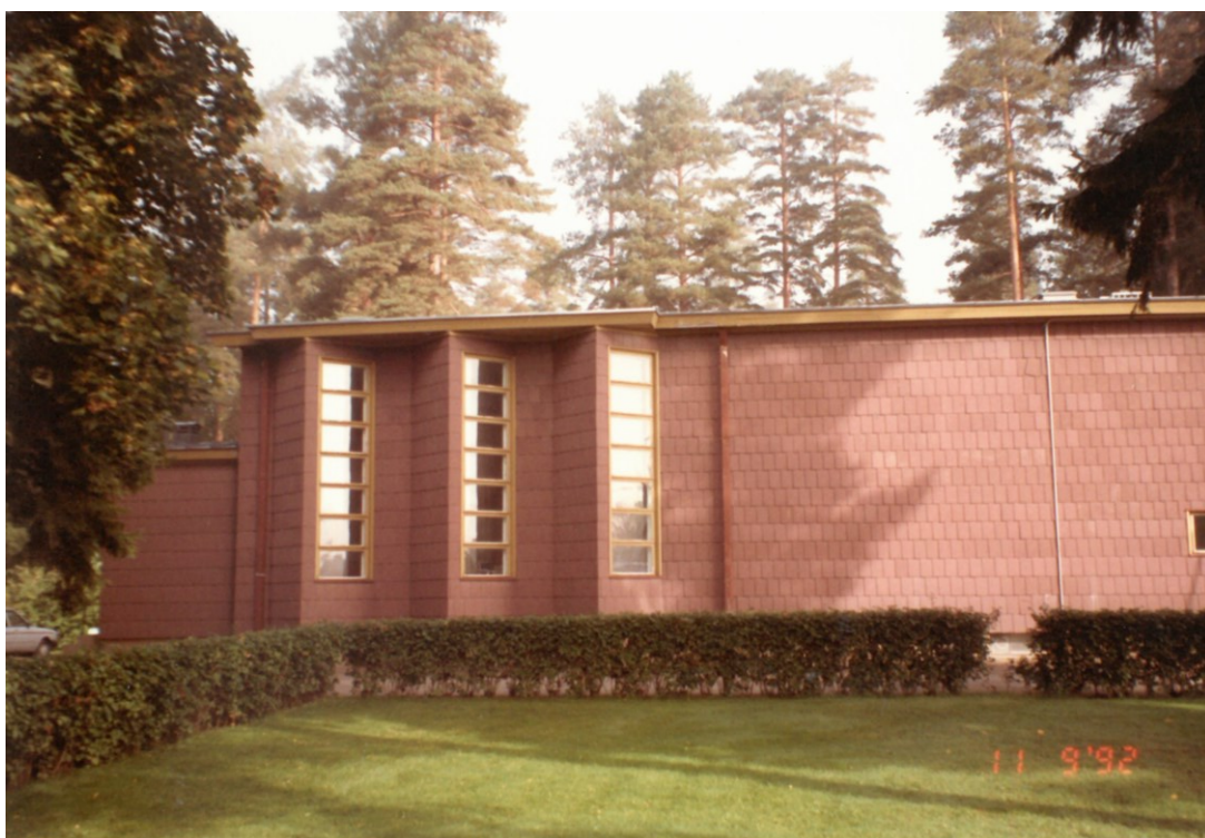
KUVA 29. Lamminpään rauhanportti, julkisivu etelään. Eronen, T. 1992. (Tampereen seurakunnat.) Julkisivussa Minerit-verhoilu.
