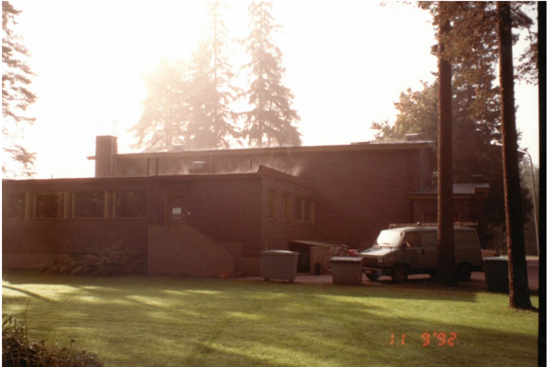
KUVA 31. Lamminpään rauhanportti, julkisivu pohjoiseen. Eronen, T. 1992. (Tampereen seurakunnat.) Julkisivussa Minerit-verhoilu.
