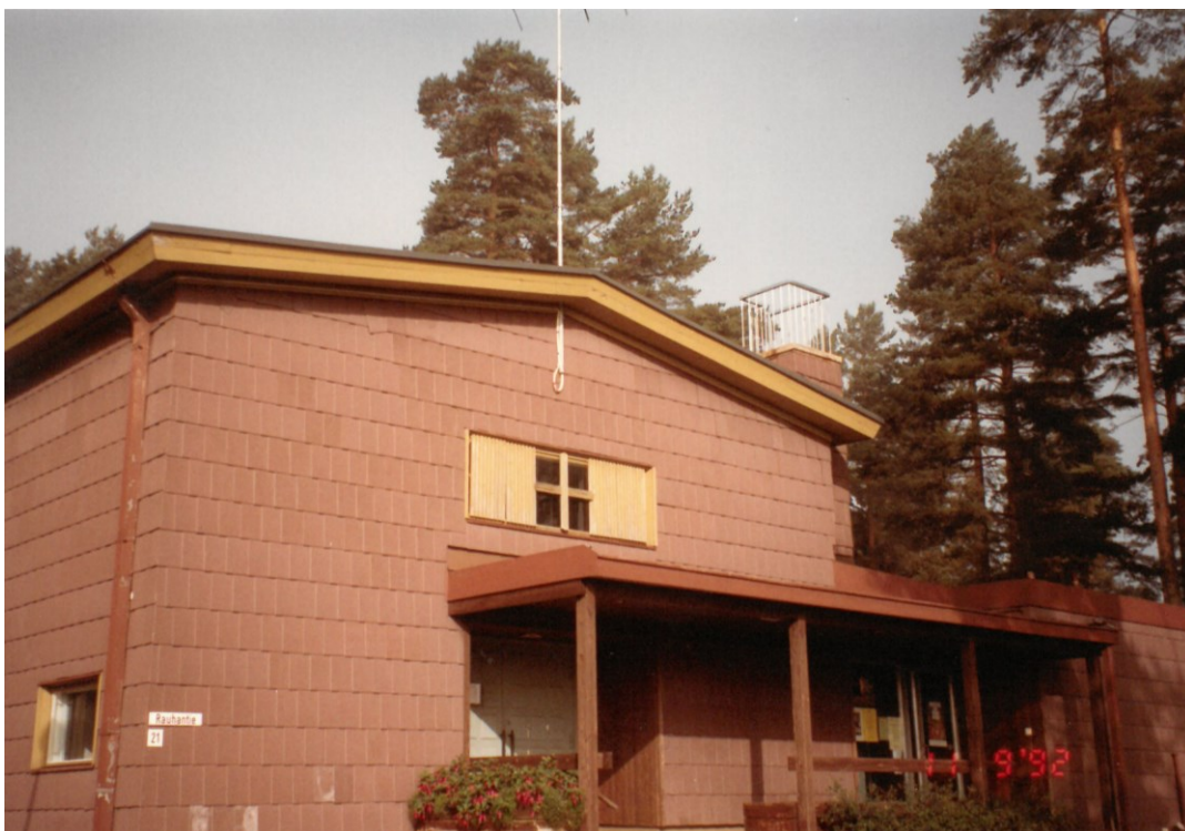
KUVA 28. Lamminpään rauhanportti, pääsisäänkäynti. Eronen, T. 1992. (Tampereen seurakunnat.) Julkisivussa Minerit-verhoilu.
