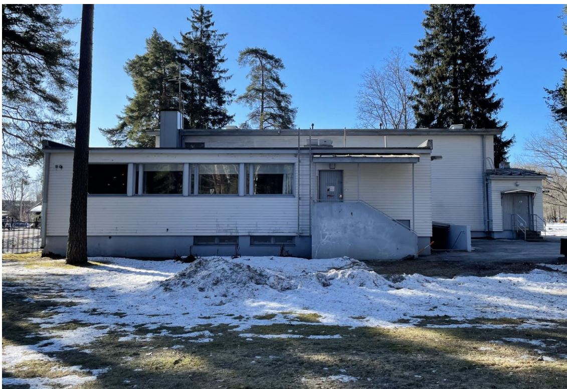
KUVA 50. Lamminpään Rauhanportti, julkisivu pohjoiseen (Kuva: Susanna Niemelä 2024).
