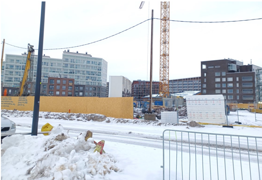
Kuva 3. Postipuistoon valmistuvan kerrostalon työmaa.
