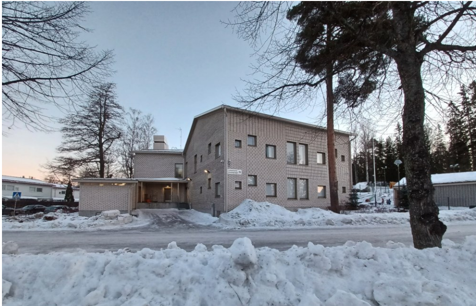
Kuva 17. Kukkiniityn päiväkodista ekskursiolla otettu rakennuksen yleiskuva.
