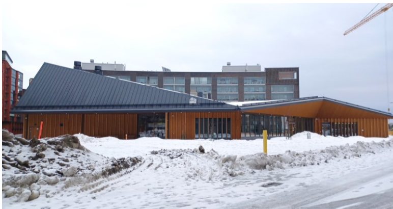
Kuva 5. Alueen puujulkisivuinen yhteiskäyttörakennus.
