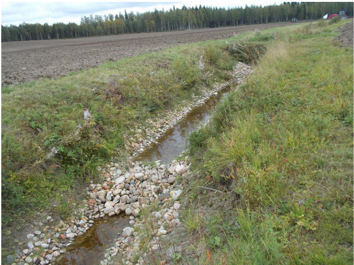
Kuva 23. Valtimon Kalliojärvelle rakennettuja pohjapatoja syyskuussa 2014. (Kuva: Tarmo Tossavainen.)
