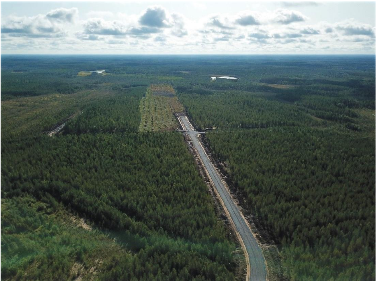
KUVA 1. Välimaan infran rakentaminen käynnistyi kesäkuussa 2019 (kuva: Toni Kunnari)
