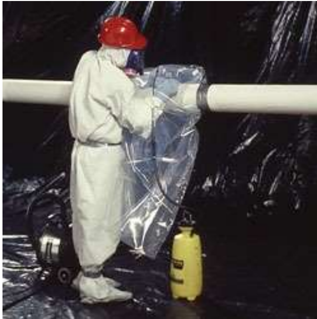
Kuvio 11. Putkieristeen poisto purkupussimenetelmällä (ASTQ supply house 2024.)
