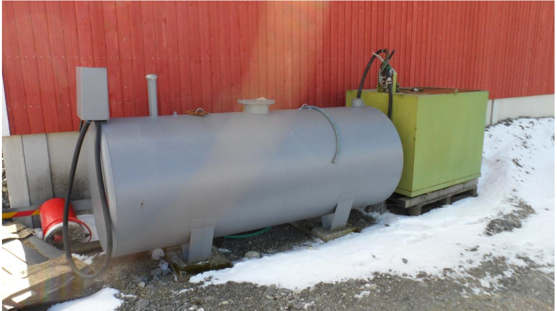
Kuva 19. Öljysäiliö on sijoitettuna siten, että alkava vuoto voidaan helposti havaita, pumput ovat lukitsematta ja asianmukaiset merkinnät puuttuvat.
