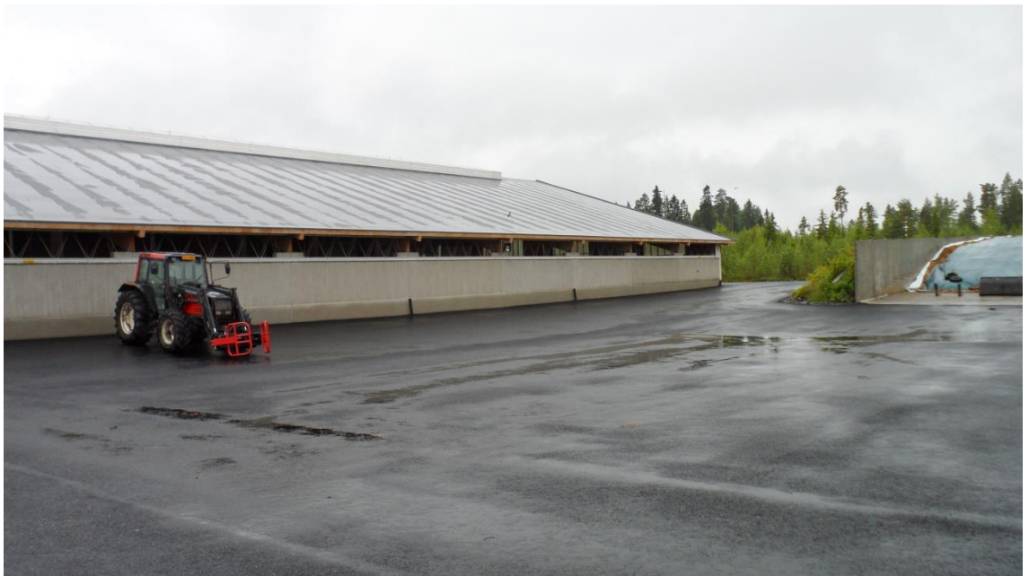
Kuva 18. Ylimääräinen materiaali poistettu rakennuksen seinustoilta, ehkäisee tuhopolttoja.
