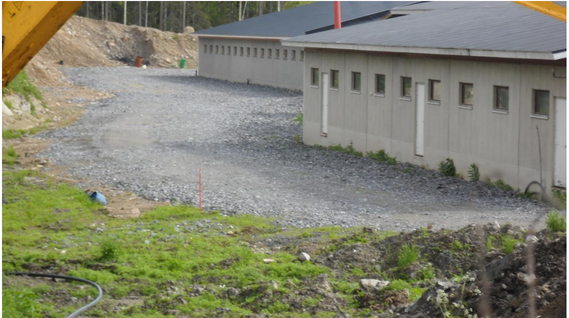
Kuva 15. Hyvin tehty pelastustie, jossa uloskäytävät näkyvät selvästi. Sisäpuolella tulee ovet olla merkittyinä poistumisopastein.
