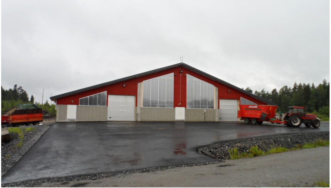
Kuva 17. Ilkivallan tekeminen on estetty kiinni olevilla lukituilla ovilla.
