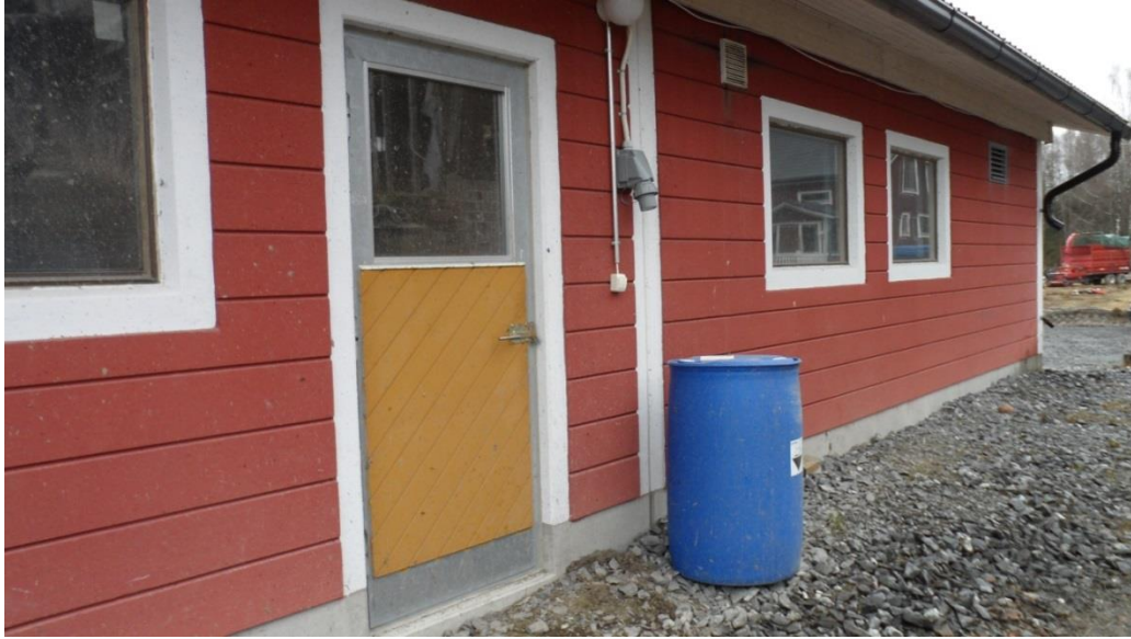
Kuva 2. Pelastussuunnitelmassa on hyvä huomioida myös sähkökatkon aikainen lisävirrän syöttö mahdollisuus.
