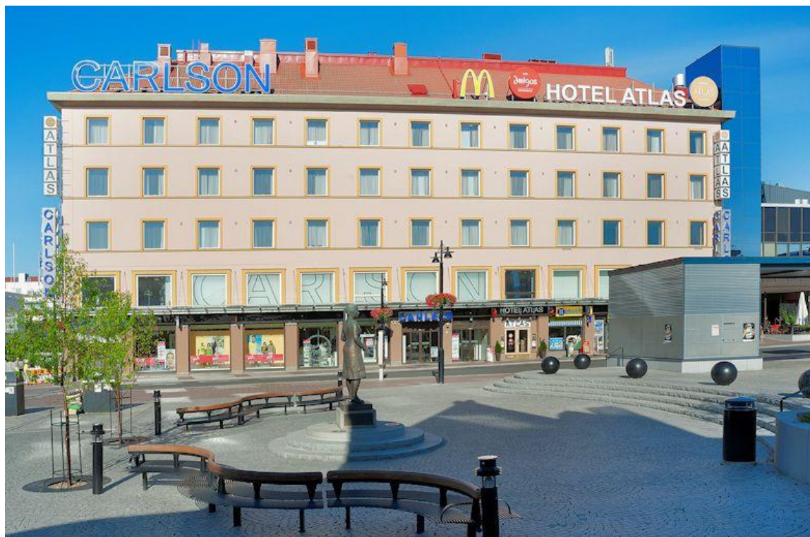
KUVA 5. Hotel Atlas julkisivu ja pääsisäänkäynti. (Hotel Atlas Kuopio.)
