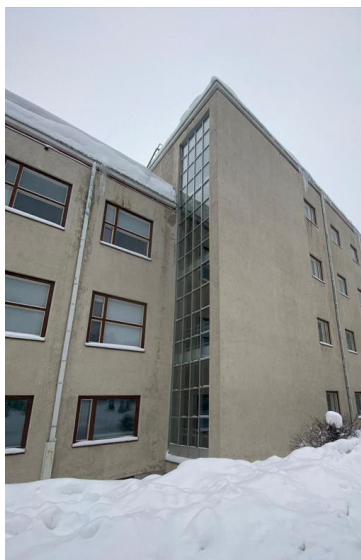
Kuva 7. Länsisiiven porrashuoneen lasijulkisivu. (Tapaninen 2024)
