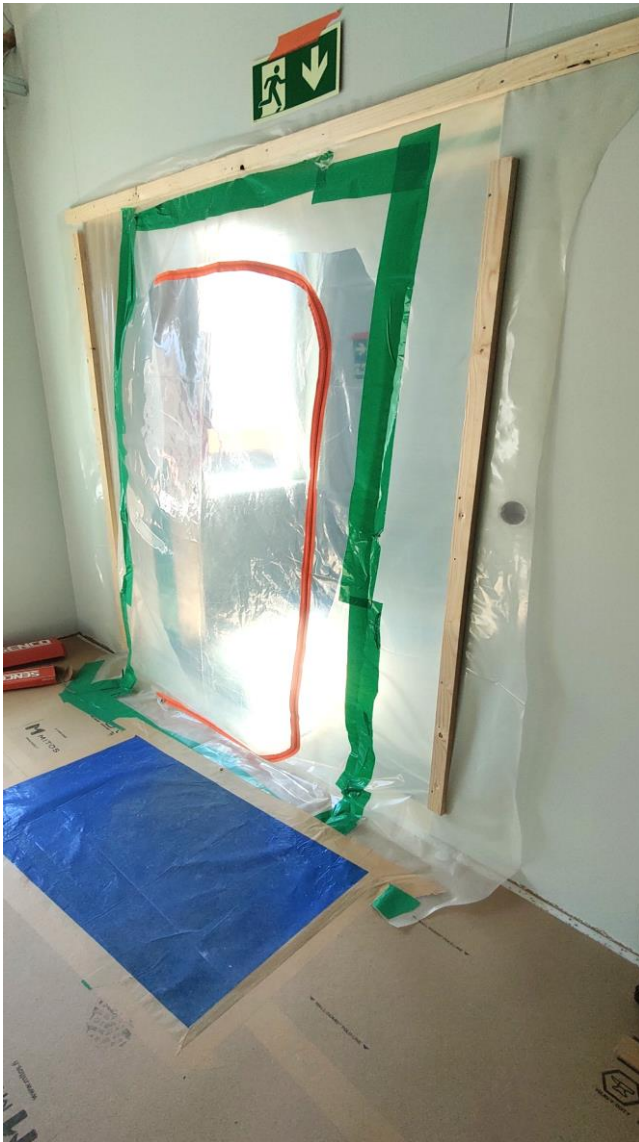
Kuva 8. Vetoketjulla suljettava osastointi ovi (Projektirakentajat JK Oy kuva-arkisto).
