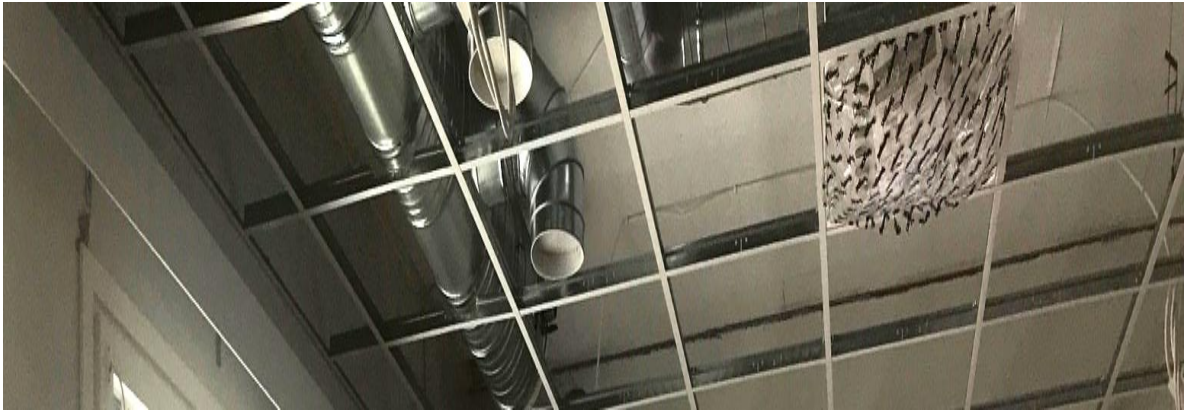
Kuva 6. Ilmanvaihtokanavan tulppaus (Projektirakentajat JK Oy kuva-arkisto).
