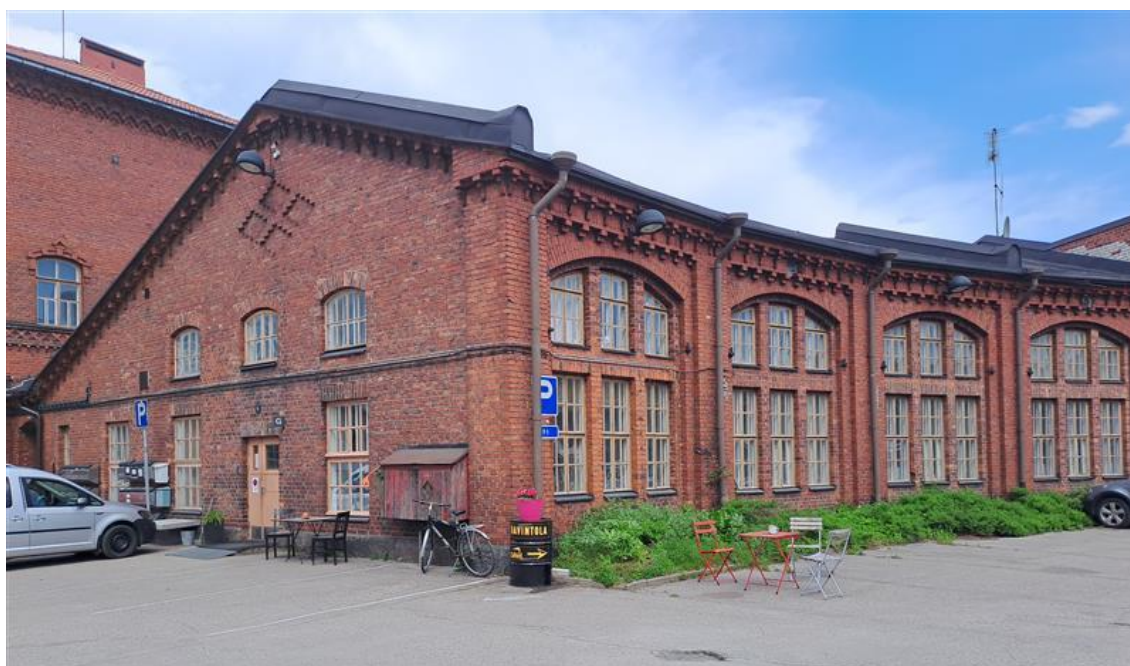
KUVA 3. Pasilan veturitallit. (Kuva: Jaakko Aumala 2024). Kuvassa näkyy sektorimallisen veturitallin harjan sijainti. Pasilan tallin käyttötarkoitus on muuttunut alkuperäisestä, mikä näkyy mm. Veturiportit korvanneilla ikkunoilla.
