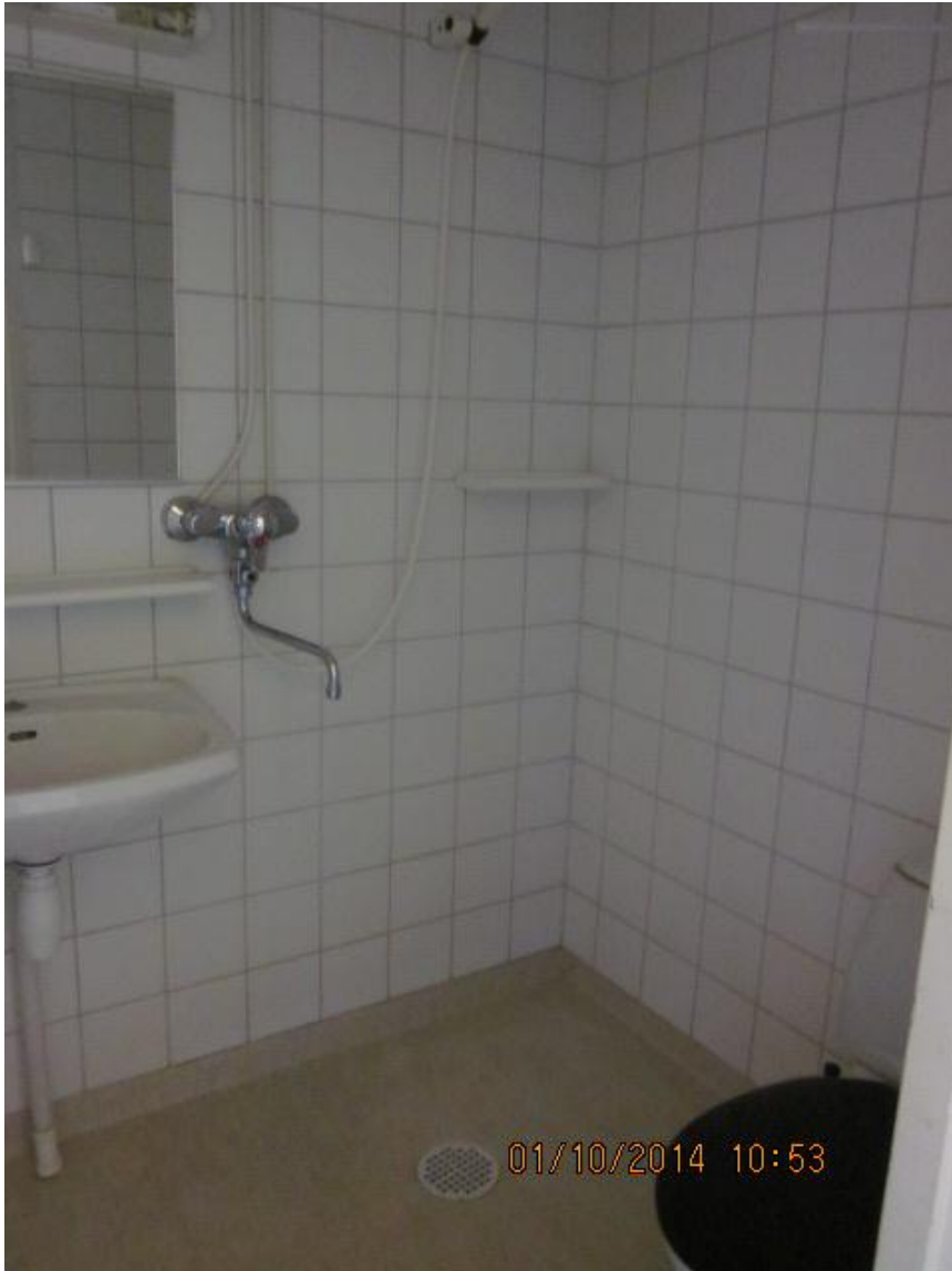
Kuva 4. Asunnon 2 B 26 kylpyhuone ennen kunnostusta. Seinälaatoitus ja vanha matto poistetaan asbestipurkuna. Seiniin tehdään vesieritys ja uusilaatoitus. Lattialle asennetaan uusi matto.
