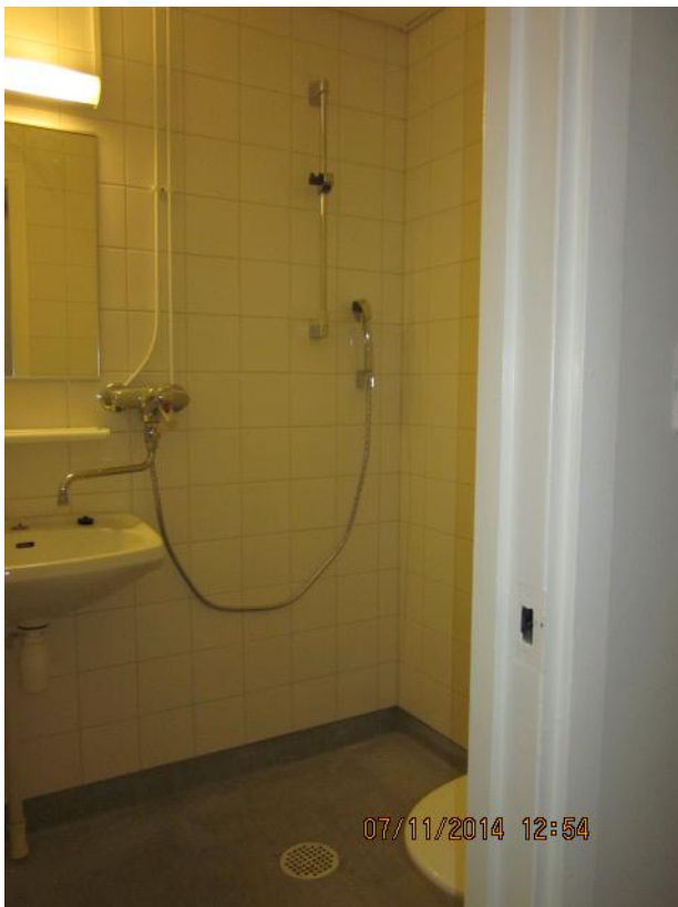
Kuva 8. Asunnon 4 A 28 märkätila kunnostustöiden jälkeen.
