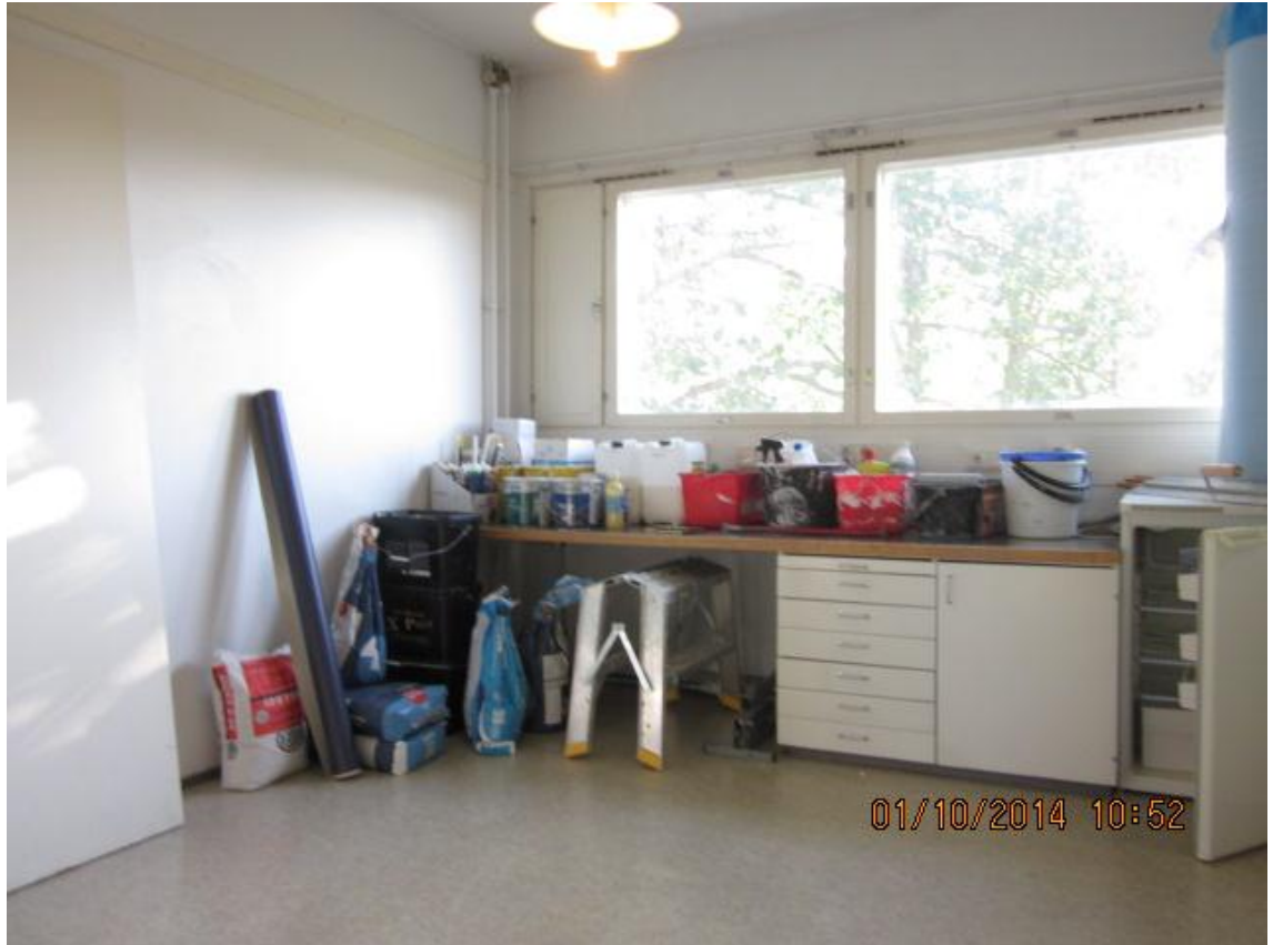
Kuva 3. Asunnon 2 B 26 ikkunaseinällä oleva pöytätaaso puretaan remontissa ja vanhan kuluneen maton päälle asennetaan laminaatti.
