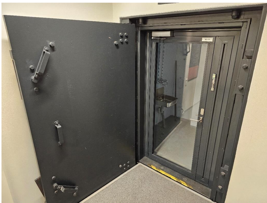
Kuva 7. Normaalikäytön ovi N8 P11 portaikon puolelta
