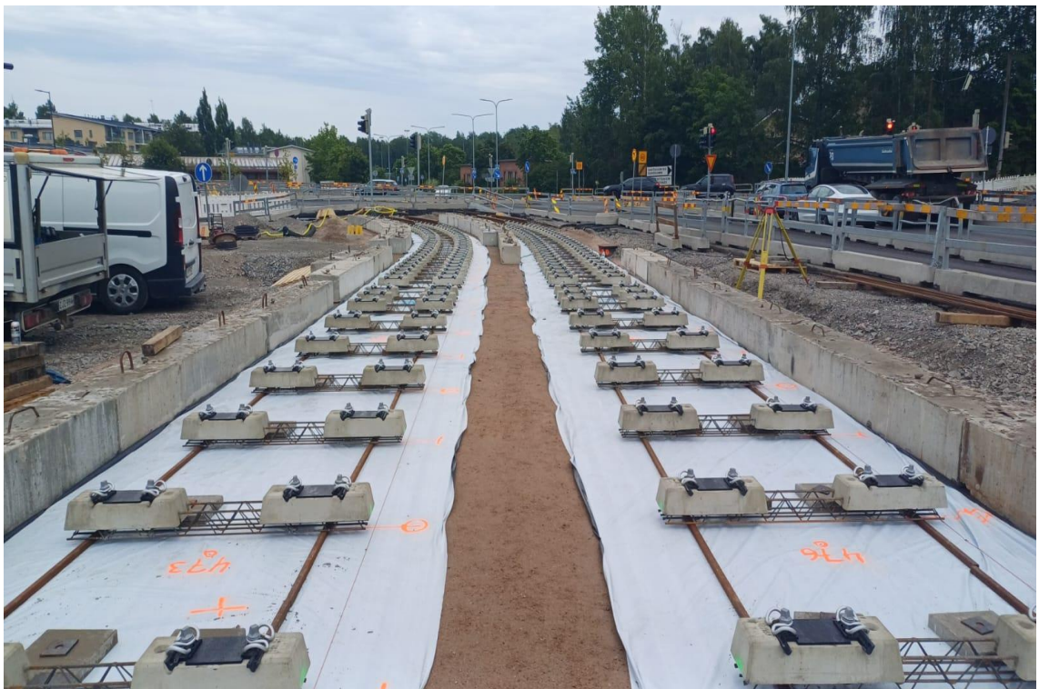
Kuva 4, Puolipölkkyt asennettu runkomelueristeen päälle. Kuva: Jukka Välikorpi
