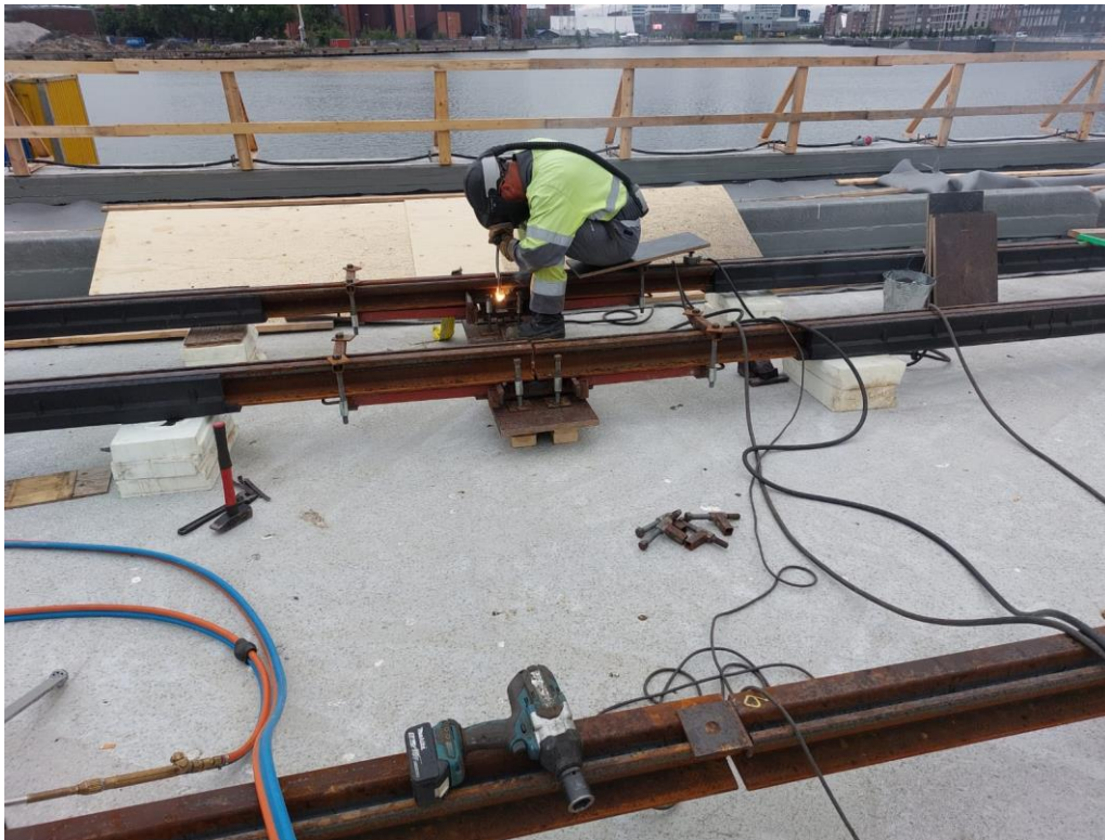
Kuva 10, Puikkohitsaus. Kuva: Jukka Välikorpi
