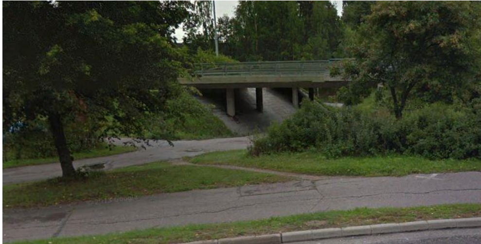
Kuva 15. Santamäentieltä Ulkoniityntielle johtava alikulku Vihdintien alla, jossa sattunut onnettomuuksia mopoilijoiden ja polkupyöräilijöiden kesken.
