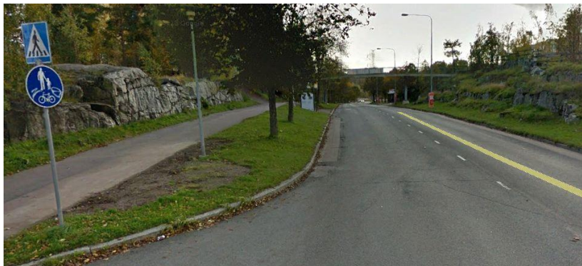
Kuva 12. Hakunilantie, ylikulku etelässä 80 m päässä
