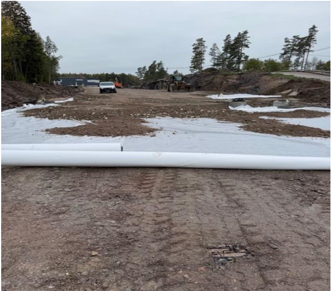
Kuva 11. Työmaalla tehdään jakava kerros EEJ-betonimursketta. (Kolabacken, katujen ja kunnallistekniikan rakentaminen)
