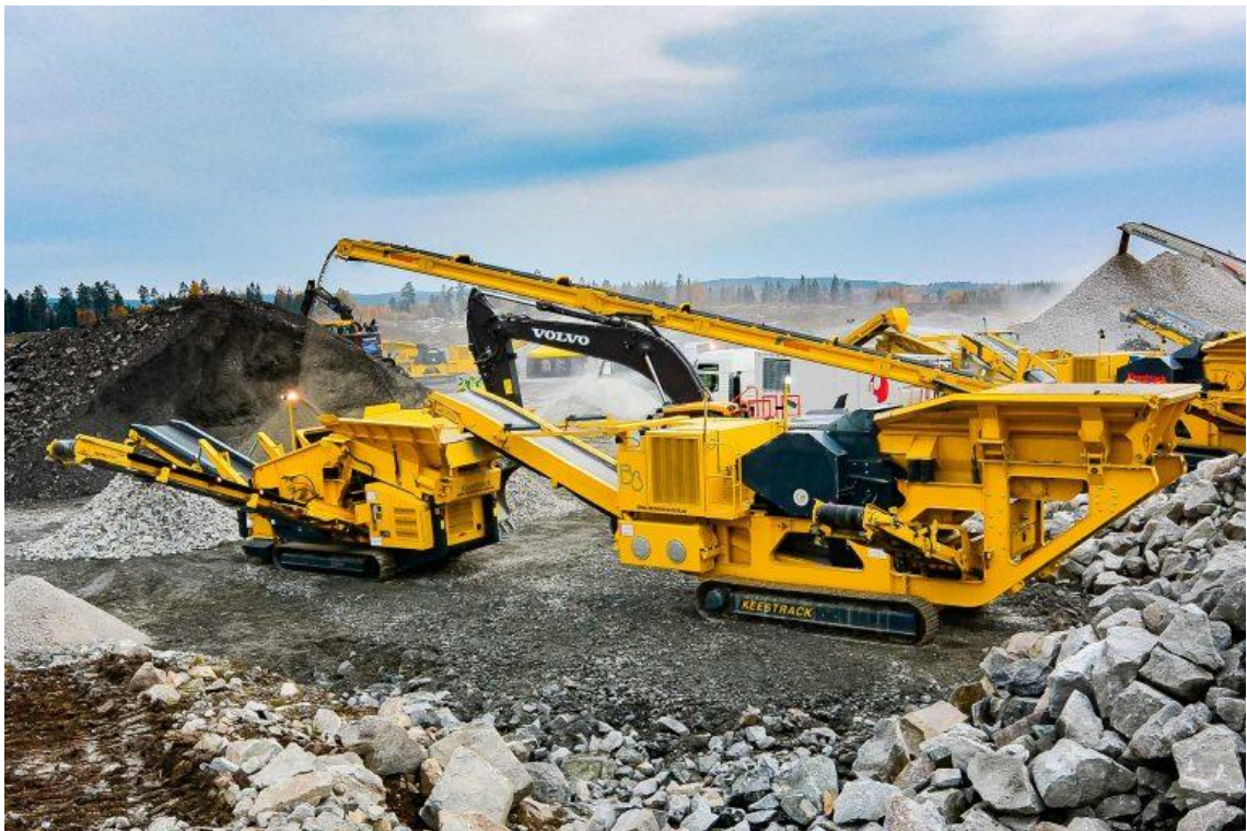
Kuva 3. Leukamurskain valmistaa tuoretta betonimursketta. (Hs Tekniikka Oy)
