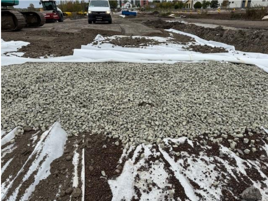
Kuva 10. Vaahtolasimurske toimii myös routaeristeenä tiekerroksissa. (Kolabacken, katujen ja kunnallistekniikan rakentaminen)
