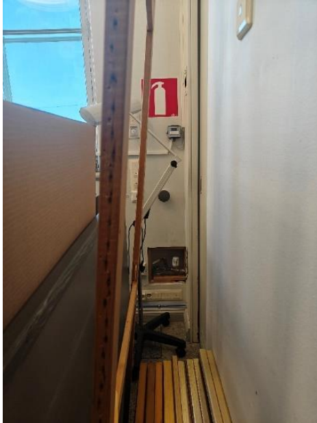
Kuva 2: Toisen kerroksen sammutinkyltti.
