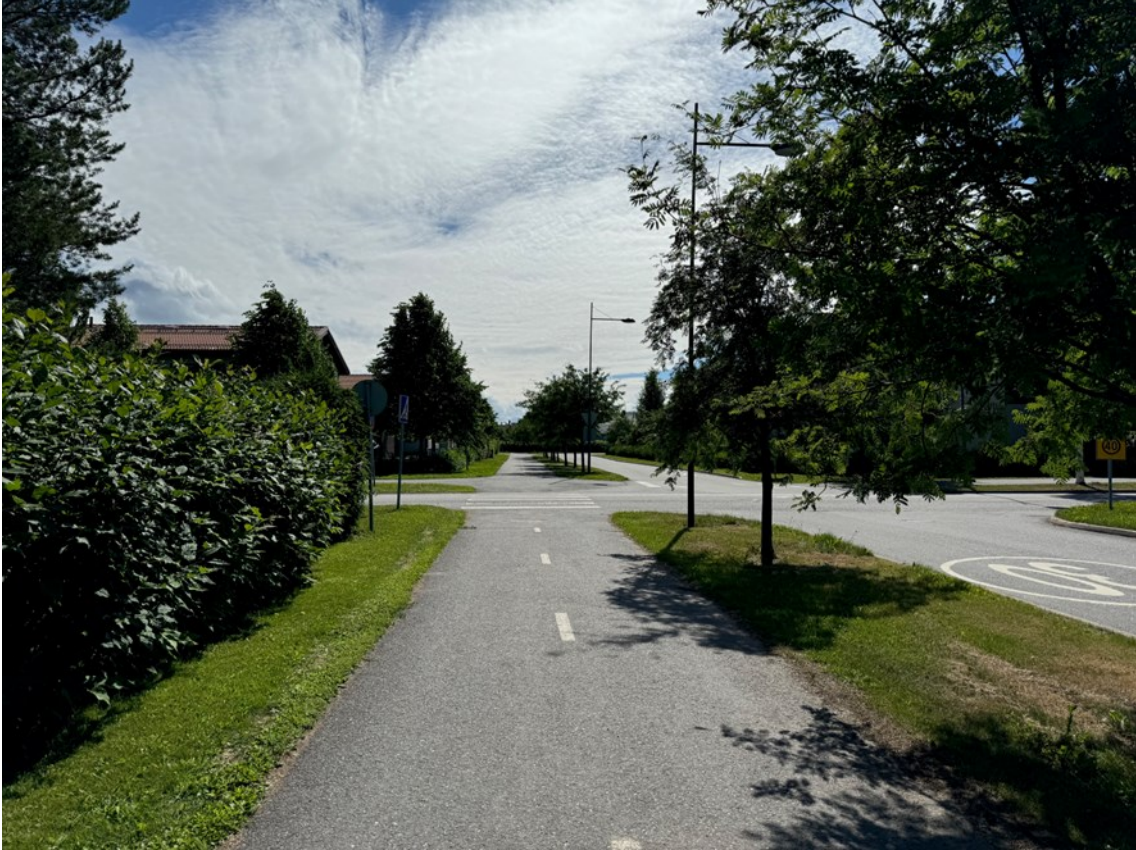
KUVA 11. Rantakukantie pohjoisesta päin risteysaluetta kohti tulevan jalankulkijan ja pyöräilijän näkökulmasta
