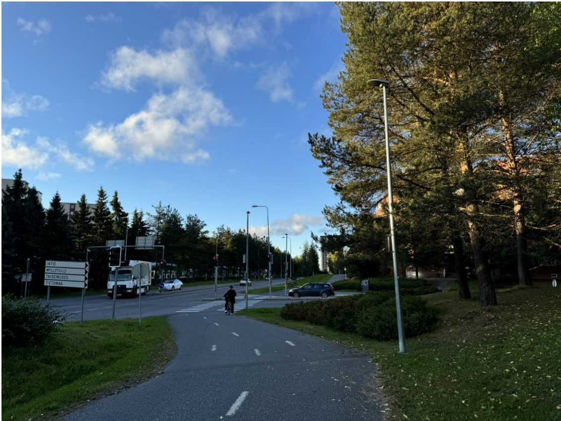
KUVA 34. Nahkatehtaankadun ja Tulliväylän risteysalue jalankulkijan ja pyöräilijän näkökulmasta
