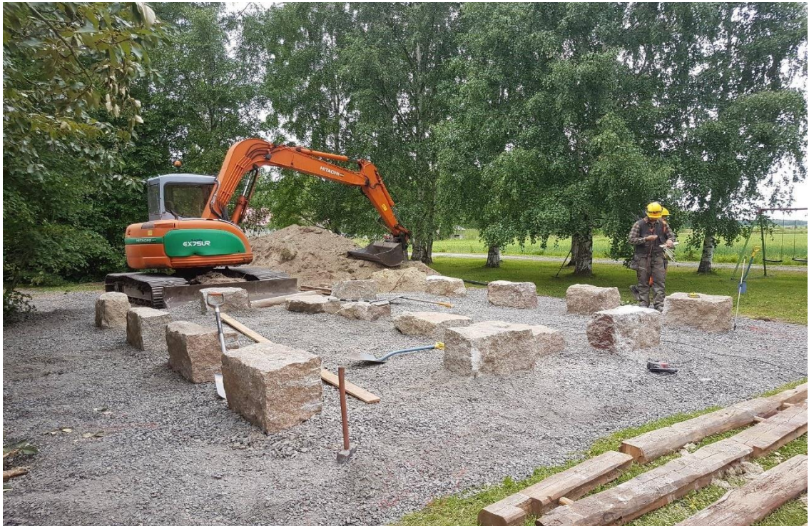
Kuva 18. Aitan perustukset (Lönroth n.d.).
