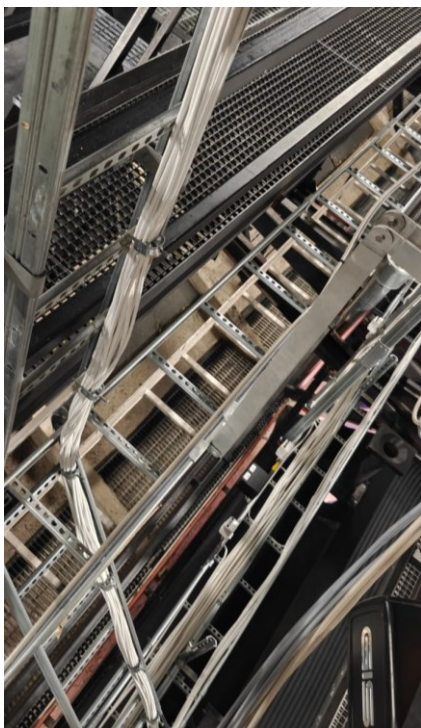
Kuva 11. Esimerkki kaapeloinnin asennuksesta tikashyllylle.
