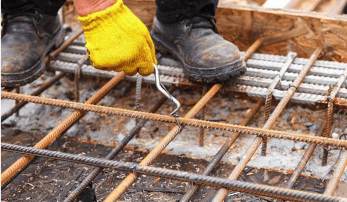
KUVA 4. Sidelankojen sidontaa raudoitustöissä. Työvälineinä ruostumatonta sidelankaa sekä sidontakoukku (Shuanglong Machinery Co. 8/2023).
