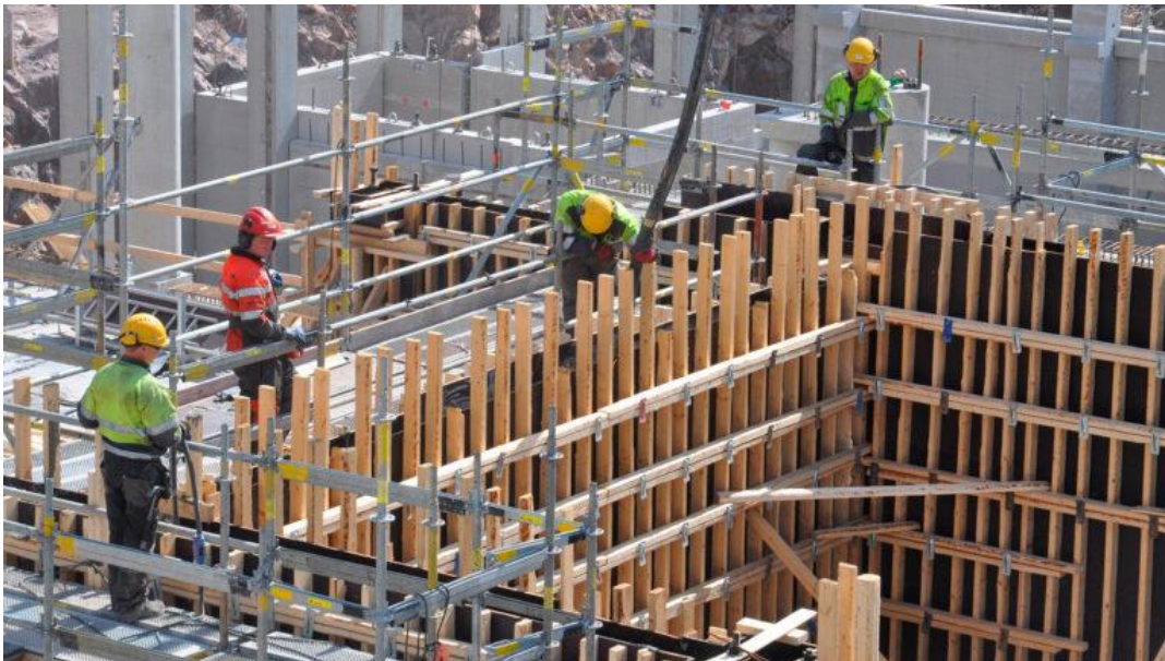
KUVA 7. Puuvalmisteinen paikallavalumuotti, jossa rakennusmateriaalina ovat vanerilevy sekä höylättyä puutavaraa (Betoniteollisuus ry 2024).
