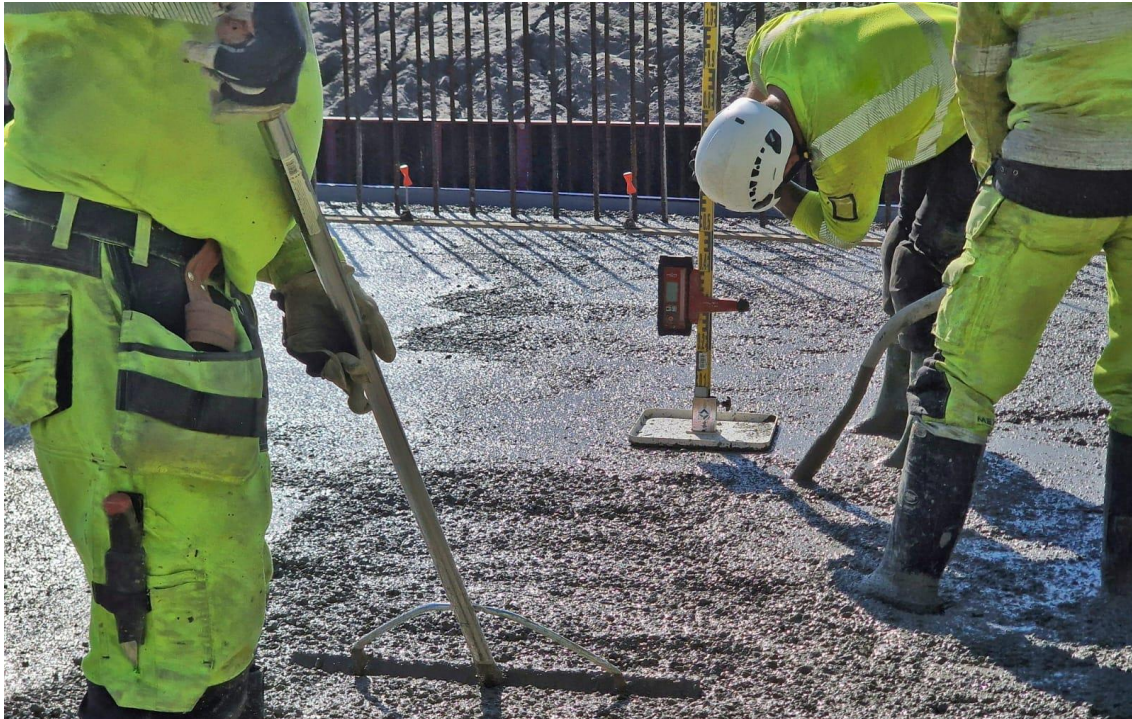
KUVA 12. Kasvojen läheisyydessä tapahtuva betonin levitys ja tiivistys aiheuttaa merkittävän riskin betonin joutumiselle silmiin tai iholle.
