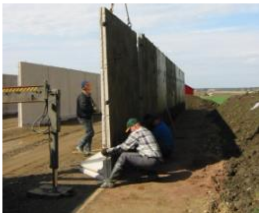
KUVA 15. Laakasiioelementtien asennusta kuormausnosturilla. (Lujabetoni, Laakasiilon rakennustapaohje, 2022)
