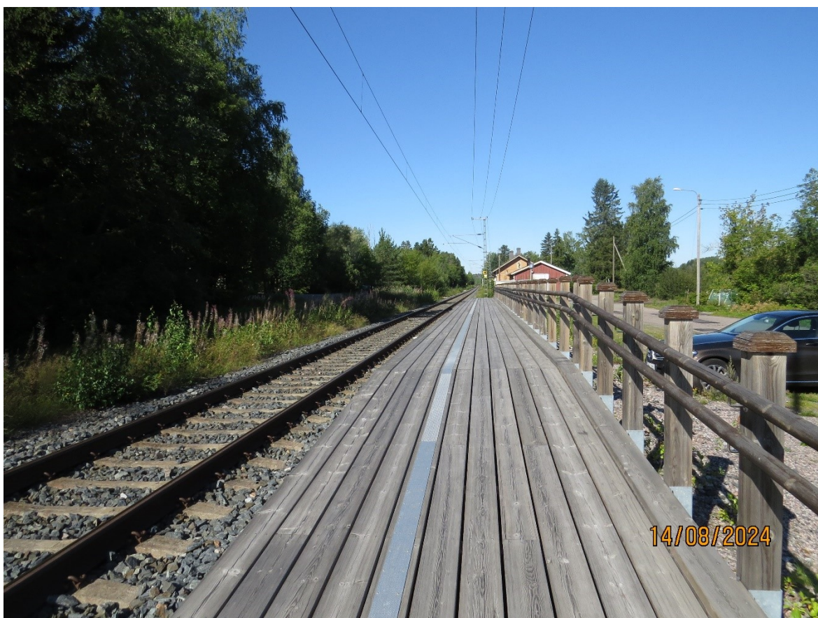
Kuva 2. Nikkilän puurakenteinen matkustajalaituri (K. Jalonen)
