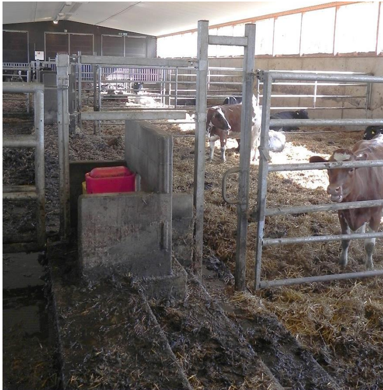
Kuva 9. Etualalla näkyy kynnyks ja ”raput”, joita pitkin eläimet nousevat lantakäytävälle. Kuvan keskivaiheilla näkyy kulkuaukko, josta hoitaja pääsee kulkemaan ilman porttien aukomista, mutta eläimet eivät niistä mahdu.
