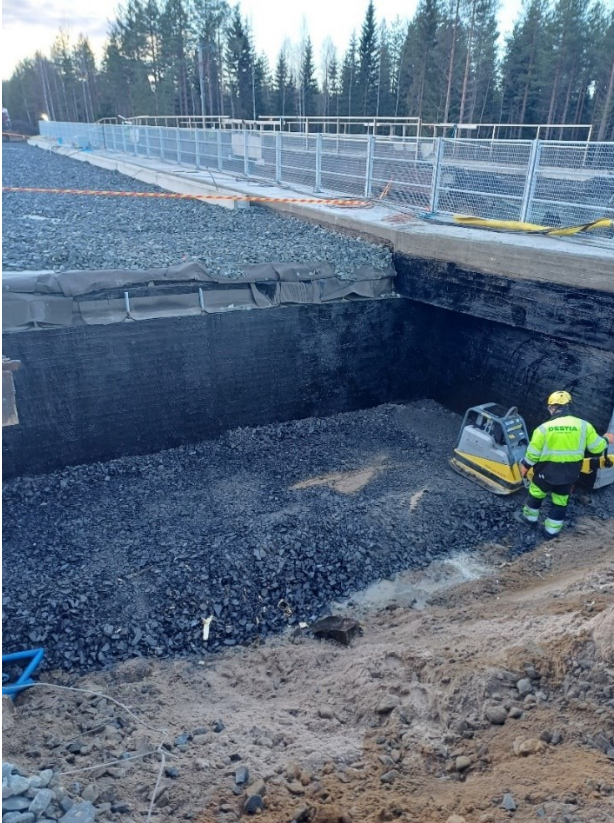
KUVA 8. Taustan täyttäminen ja tiivistäminen.
