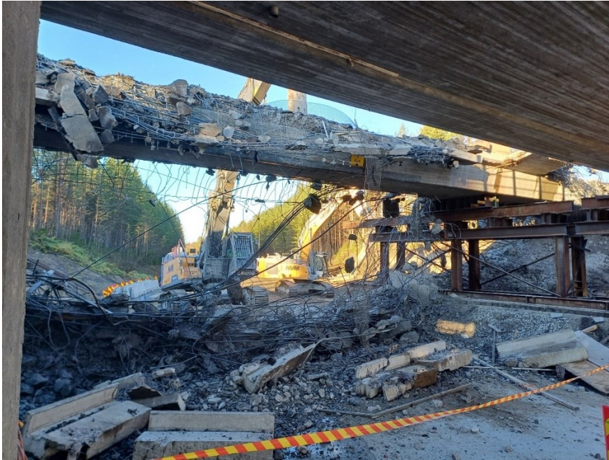
KUVA 9. Vanhan sillan purkaminen iskuvasaralla
