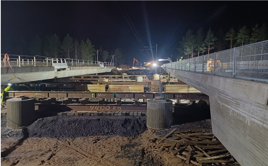
KUVA 7. Uuden sillan siirto käynnissä
