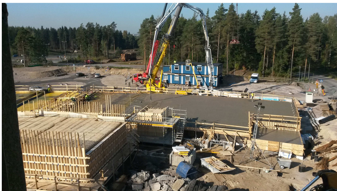
Kuva 29. Kivikon ensimmäisen kerroksen ensimmäisen lohkon valu. Valussa käytettiin 42 metrin pituisia pumppua.
