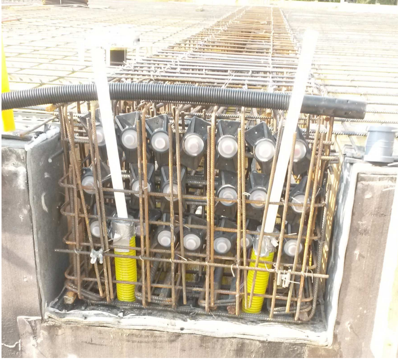
Kuva 16. Palkin pään raudoitus, passiiviankkurit ja putkitus Kivikon työmaalla.
