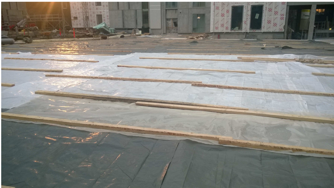
Kuva 36. Jätkäsaaren toisen lohkon päälle on levitetty valun jälkeisenä yönä routamatto ja pressu. Suojien paikallaan pysyminen kannattaa varmistaa esimerkiksi asettamalla koolingit niiden päälle.
