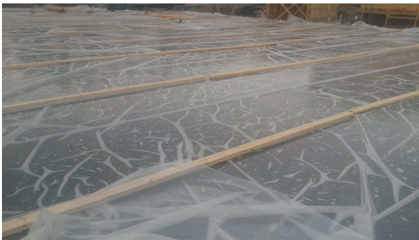
Kuva 34. Kivikon ensimmäisen kerroksen ensimmäinen valulohkon jälkihoito hoidettiin muovittamalla koko kenttä mahdollisimman varhaisessa vaiheessa (eli seuraavan illan ja yön aikana).
