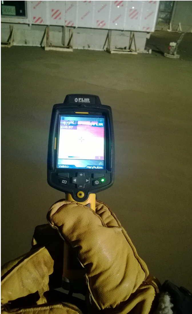
Kuva 35 - Talvella on syytä tarkkailla betonin pinnan lämpötilaa. Jätkäsaaren toinen lohko valettiin 2.12.2013. Valun pinta on hierron jälkeen hieman alle 5 celsiusasteen. Pian tämän jälkeen kun betonin pintaan ei enää tule vaurioita sen päällä käveltäessä, valun päälle levitettiin routamatto ja pressu.
