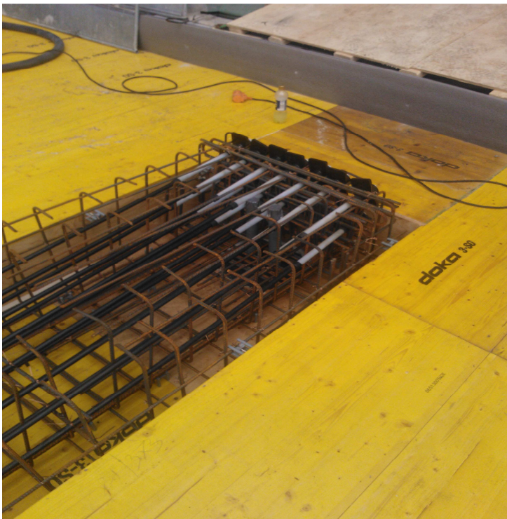
Kuva 15. Palkin pään raudoitus ja punoksien passiiviankkurit Jätkäsaaren työmaalla. Passiiviankkurit jäävät kokonaisuudessaan valuun sisälle.
