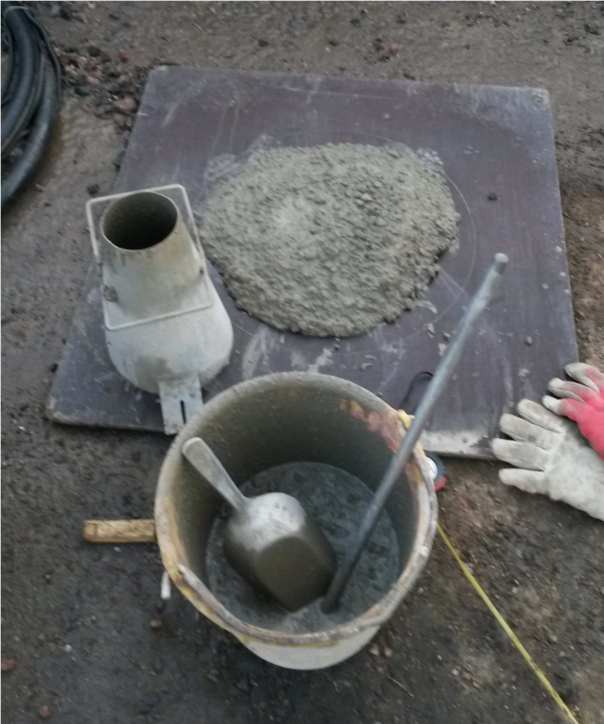
Kuva 27. 1-luokan betonirakenteissa laadunvalvonta on tärkeässä asemassa (Kuva Kivikon työmaan 1-kerroksen 1-lohkon valusta). Tämän betonin notkeus on S4/ 20 cm valuman tasoa.
