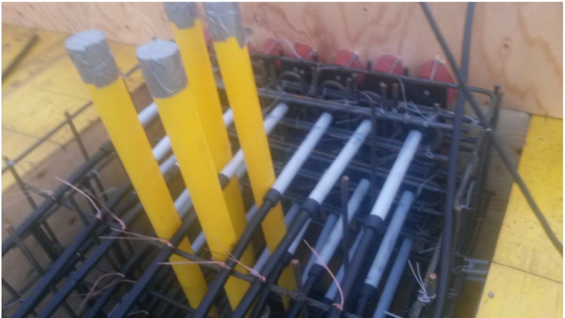
Kuva 17. Palkin pään raudoitus ja punoksien aktiiviankkurit sekä pilarin tappien putkitus.
