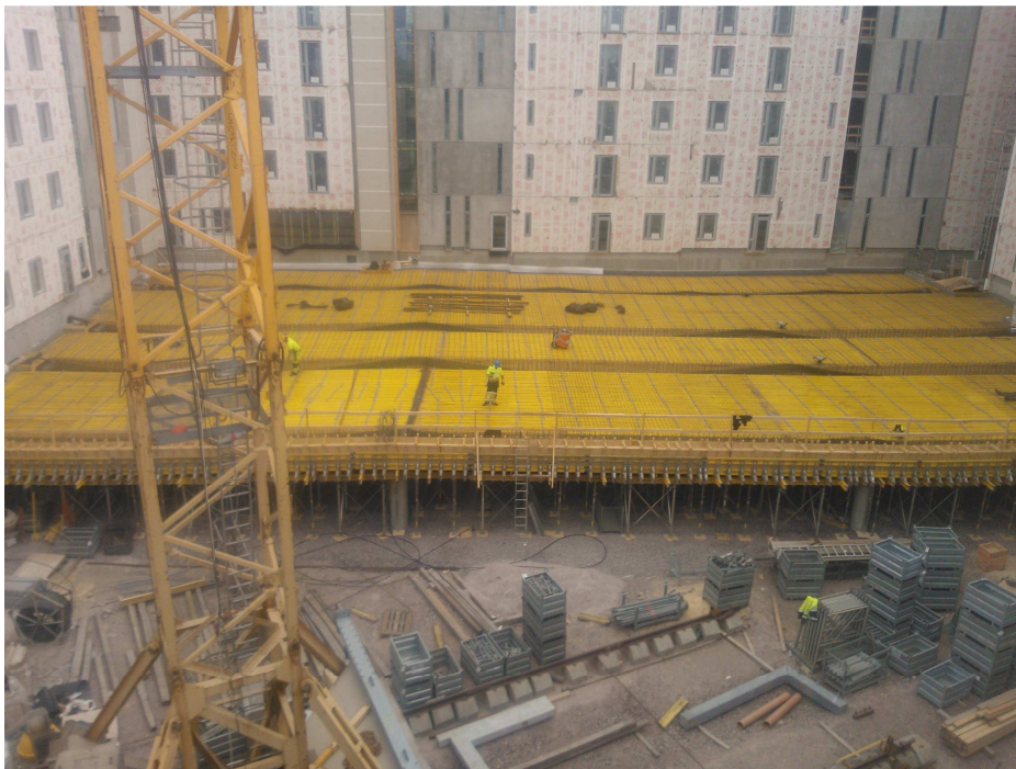
Kuva 12 - Jätkäsaaren holvilla aloitettu laatan alapintojen terästen asennus
