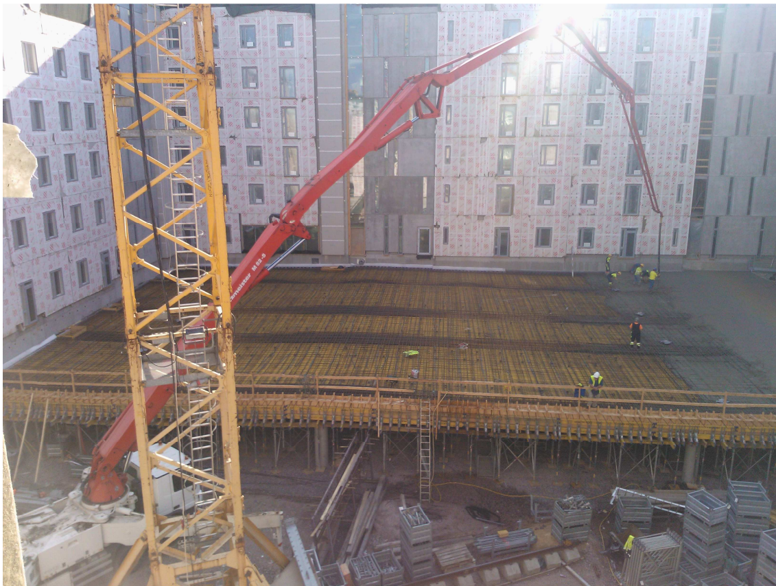
Kuva 28. Jätkäsaaren kannen ensimmäisen lohkon betonointi. Käytössä 52 metrin pituinen betoni-pumppu.
