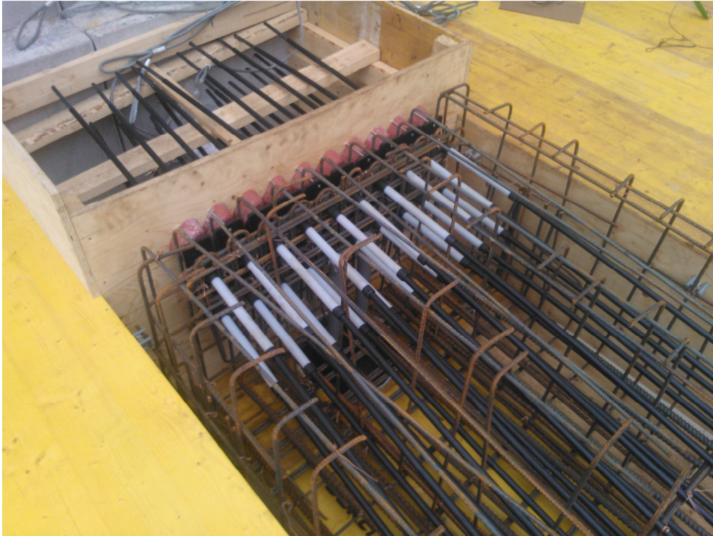
Kuva 14. Palkin pään raudoitus ja punoksien aktiiviankkurit Jätkäsaaren työmaalla. Kuva punoksien asentamisen jälkeen.
