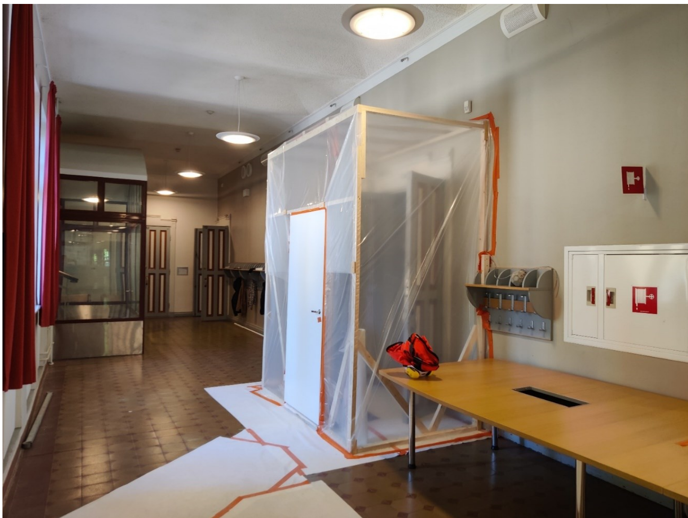
KUVA 11. Sulkutila valmiina, ovena laakaovi paremman tiiveyden ja kestävyuden vuoksi (Manninen 2024 CC BY-ND).
