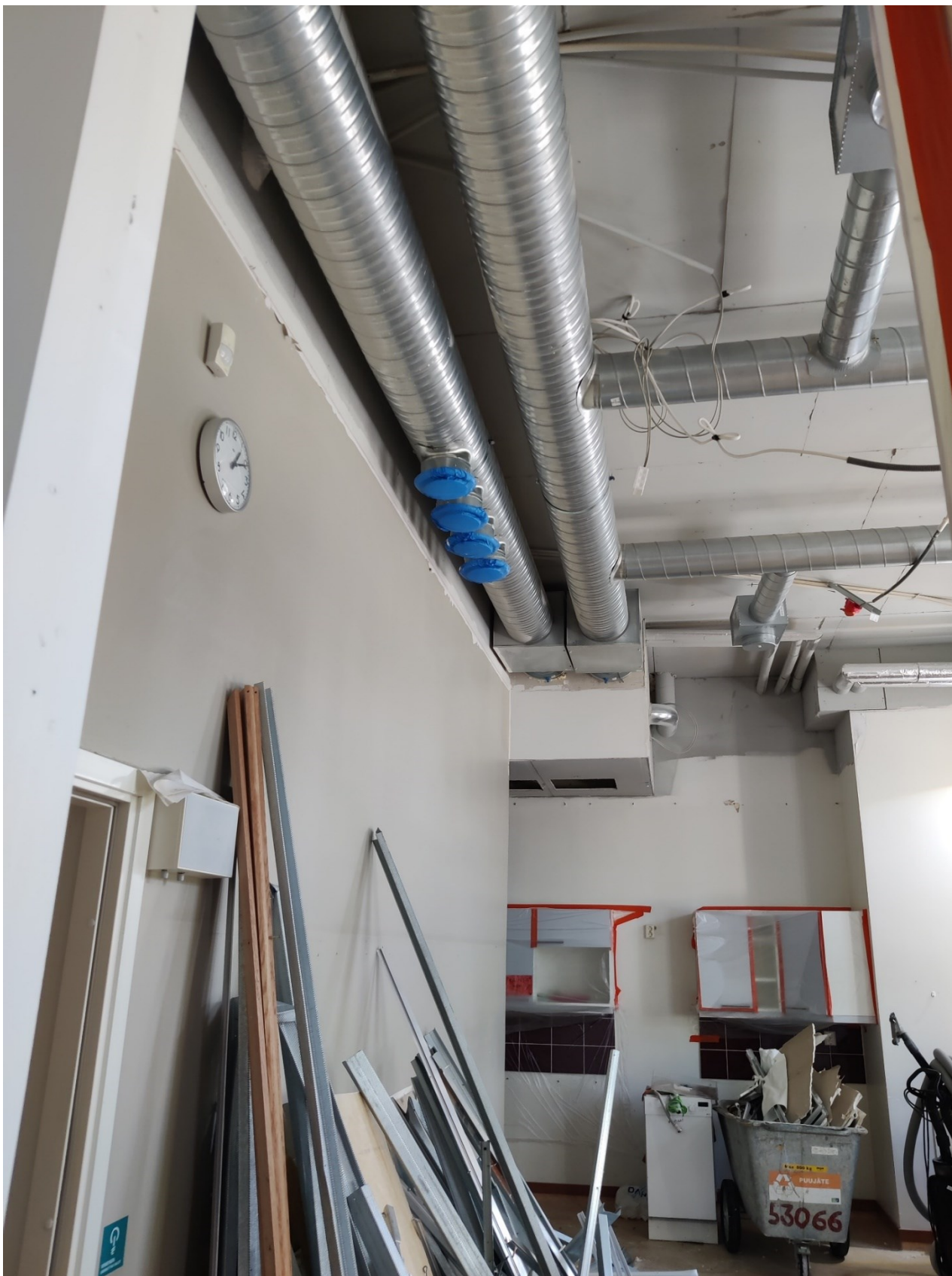
KUVA 4. Puruvaihe käynnissä. Roskat lajitellaan ja viedään "mersulla", jonka voi tarvittaessa suojata muovilla tai metallisella kannella estämään pölyn kulkeutumisen puhtaisiin tiloihin matkalla roskalavalla (Manninen 2024 CC BY-ND).
