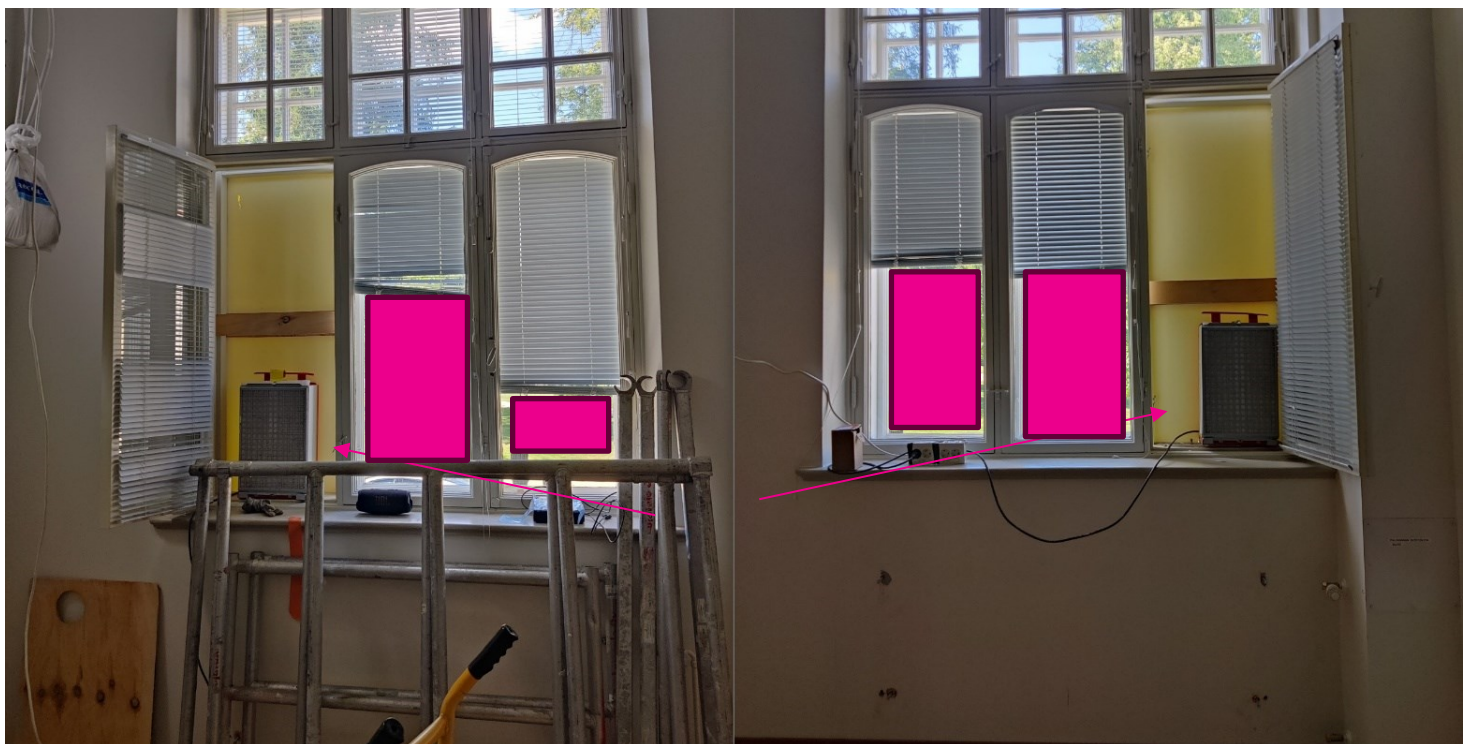
KUVA 9. Alipaineistajat paikoillaan, aukot tiivistetty uretaanilevyllä (Manninen 2024 CC BY-ND).
