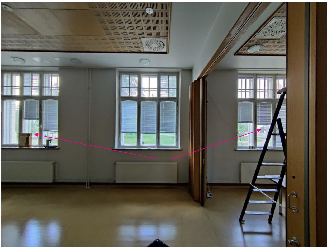
KUVA 8. Suojausten ja alipaineistusten valmistelua. Alipaineistajat sijoitetaan nuolella merkittyihin ikkunoihin (Manninen 2024 CC BY-ND).
