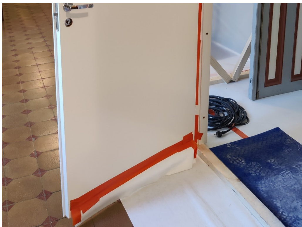
KUVA 13. Laakaoven alaosaan lisätty tiiviste tiiveyden parantamiseksi, kuvassa näkyvissä myös tarramatto poistamassa pölyä kenkien pohjista (Manninen 2024 CC BY-ND).
