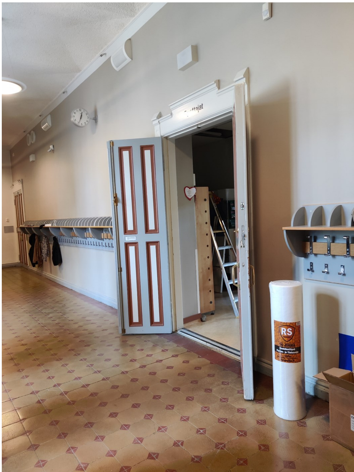
KUVA 10. Työmaan aloitustilanne, kuva oviaukolta, josta mennään työmaalle (Manninen 2024 CC BY-ND).
