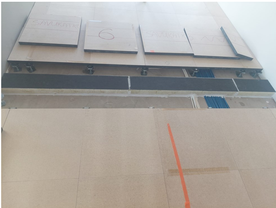
Kuva 18. Savukatko asennettuna asennuslattian alapuolelle
