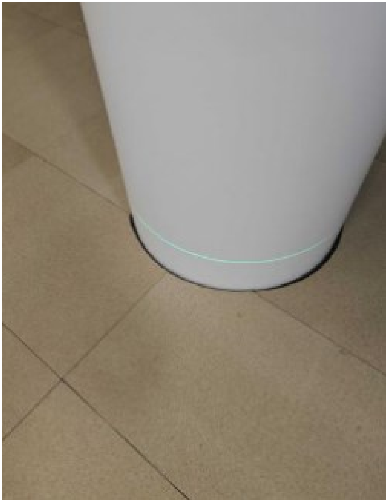
Kuva 16. Pilarien ympäryställe asennetut asennuslattialevyt.
