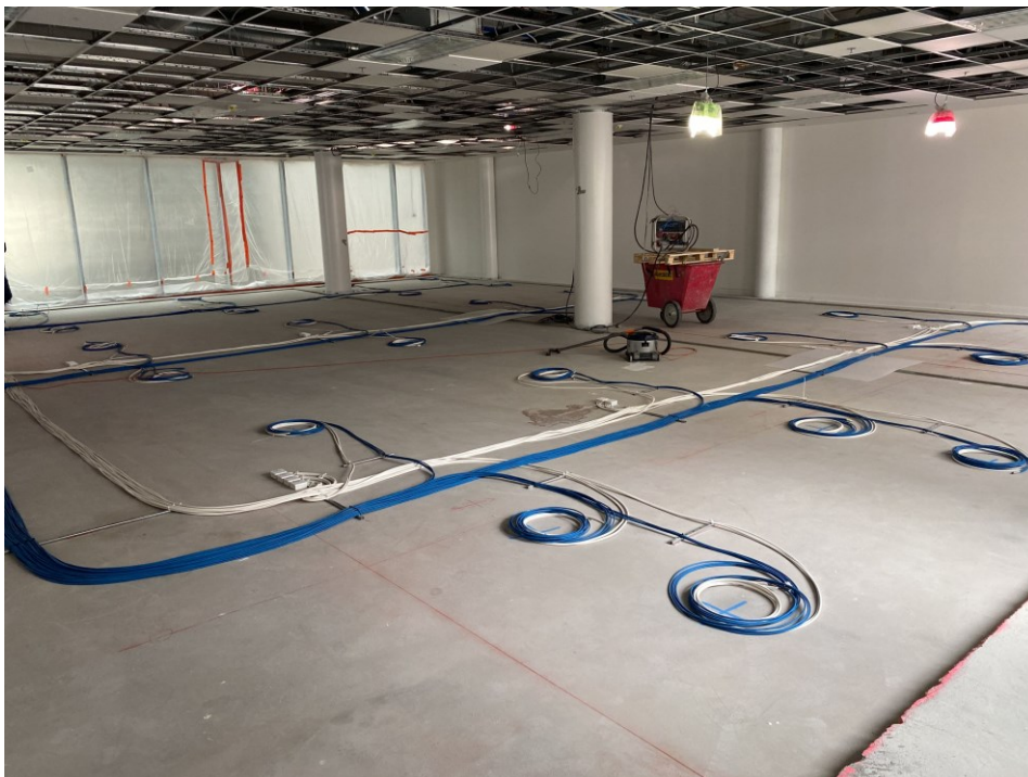
Kuva 13. Lattiakaapelien sekä jakorasioiden asennuksia.
