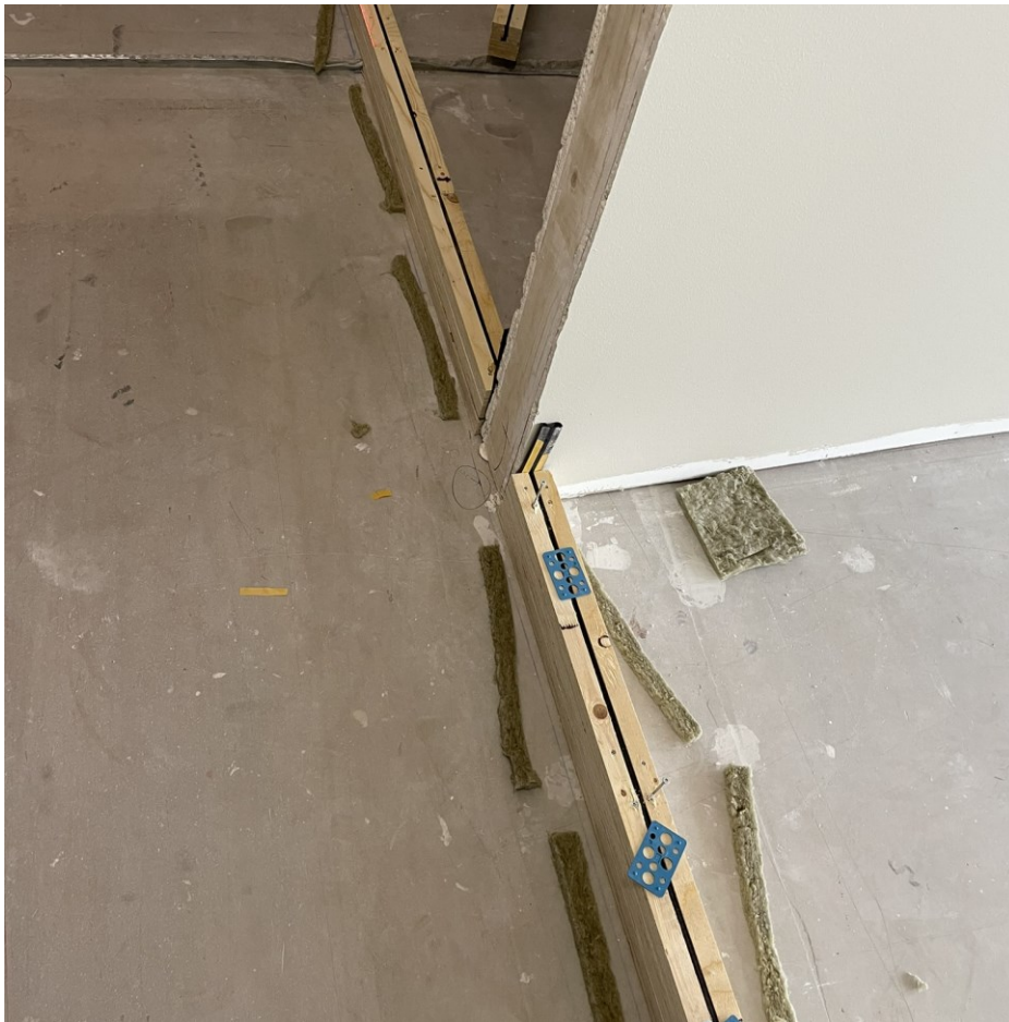
Kuva 11. Rakenteilla oleva puurunkoinen sokkelirakenne Boostin työmaalta.
