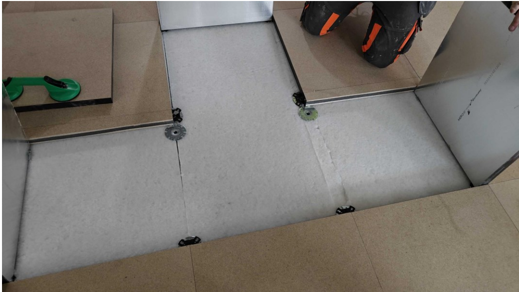
Kuva 17. Akustiikkavillat asennuslattian alapuolella Boostin työmaalla
