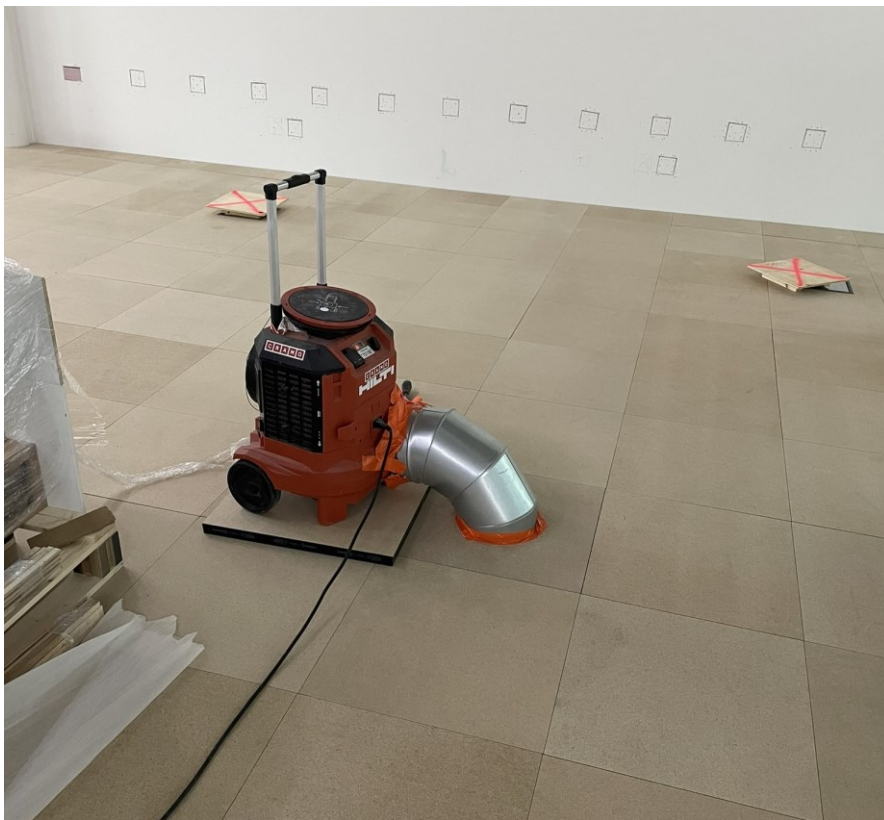
Kuva 15. Asennuslattian alapuolisen tilan ylipaineistus Boostin työmaalla.
