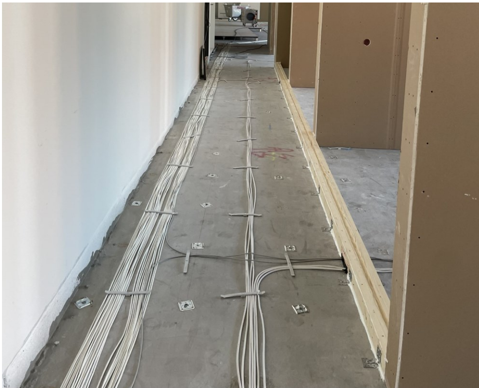
Kuva 12. Lattiakaapelointien asennuksia We Landin työmaalta.
