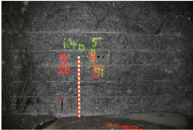
Kuva 53. Hyvän poraustarkkuuden jäljiltä siistiä seinämää
