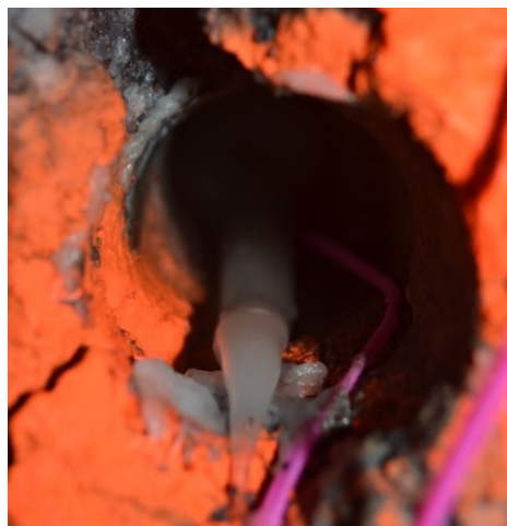
Kuva 52. 350 g/m K810 emulsiorantu porausreiässä (Oy Forcit Ab)
