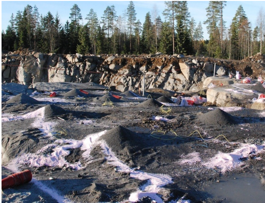
Kuva 3. Kuva Anfopanostus työmaalta (Oy Forcit Ab)
