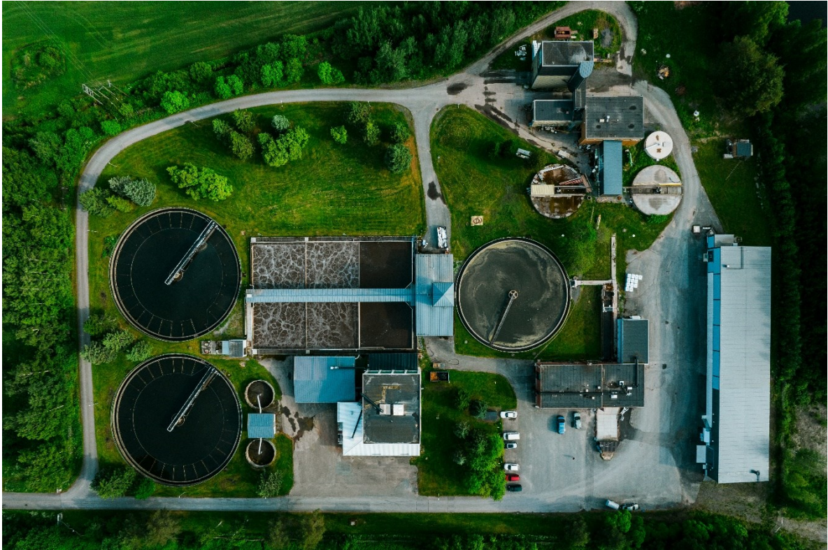
KUVA 1. Ilmakuva jätevedenpuhdistamon alueesta (4)
