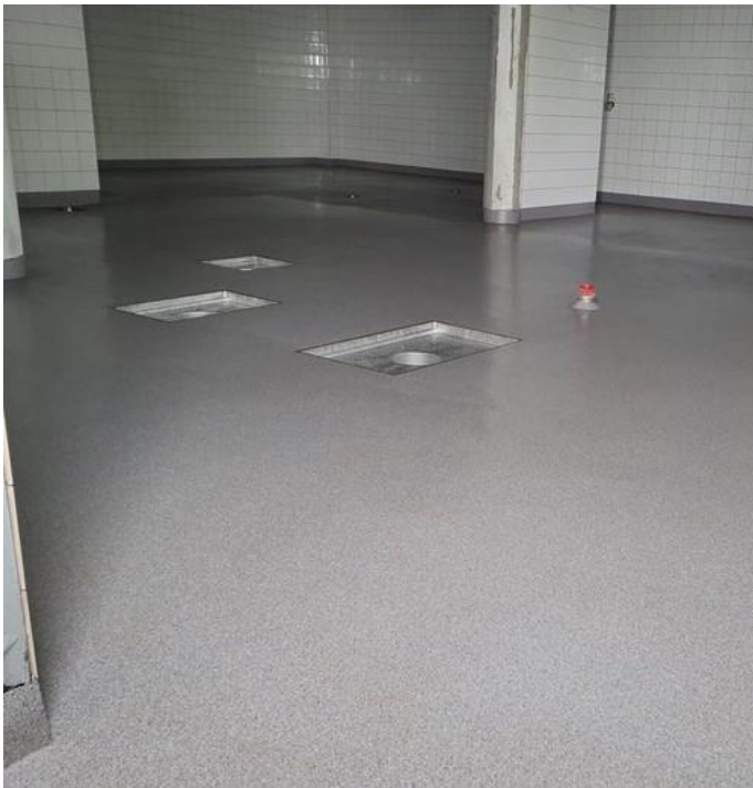
Kuva 12. (Epoksi massapäälyste. Suomenepoksilattiat.fi. 2024.)
