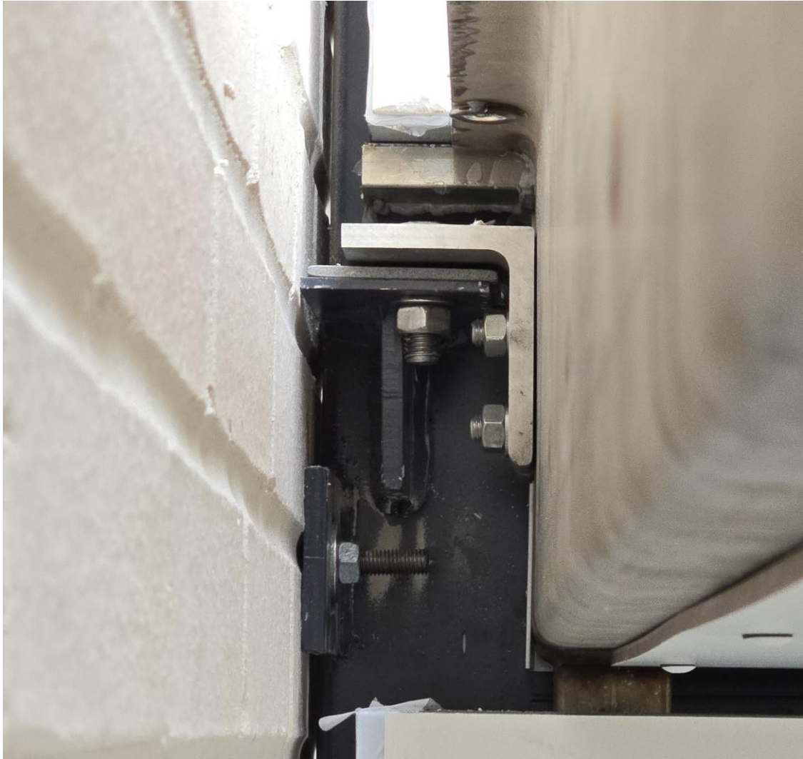
Kuva 13. Parveke-elementin kiinnitys parvekepilariin. (Lappalainen 2024)
