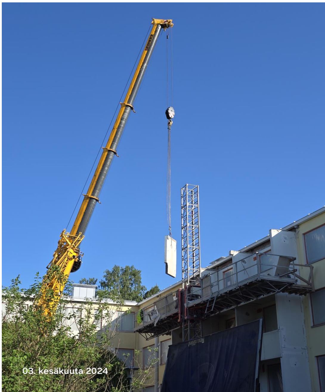
Kuva 6. Parvekkeiden purkua sahaamalla parvekkeet paloiksi kiskosahalla. Kuvassa nosturi on nostamassa sahattua parvekeseinää betonilavalle. (Lappalainen 2024)
