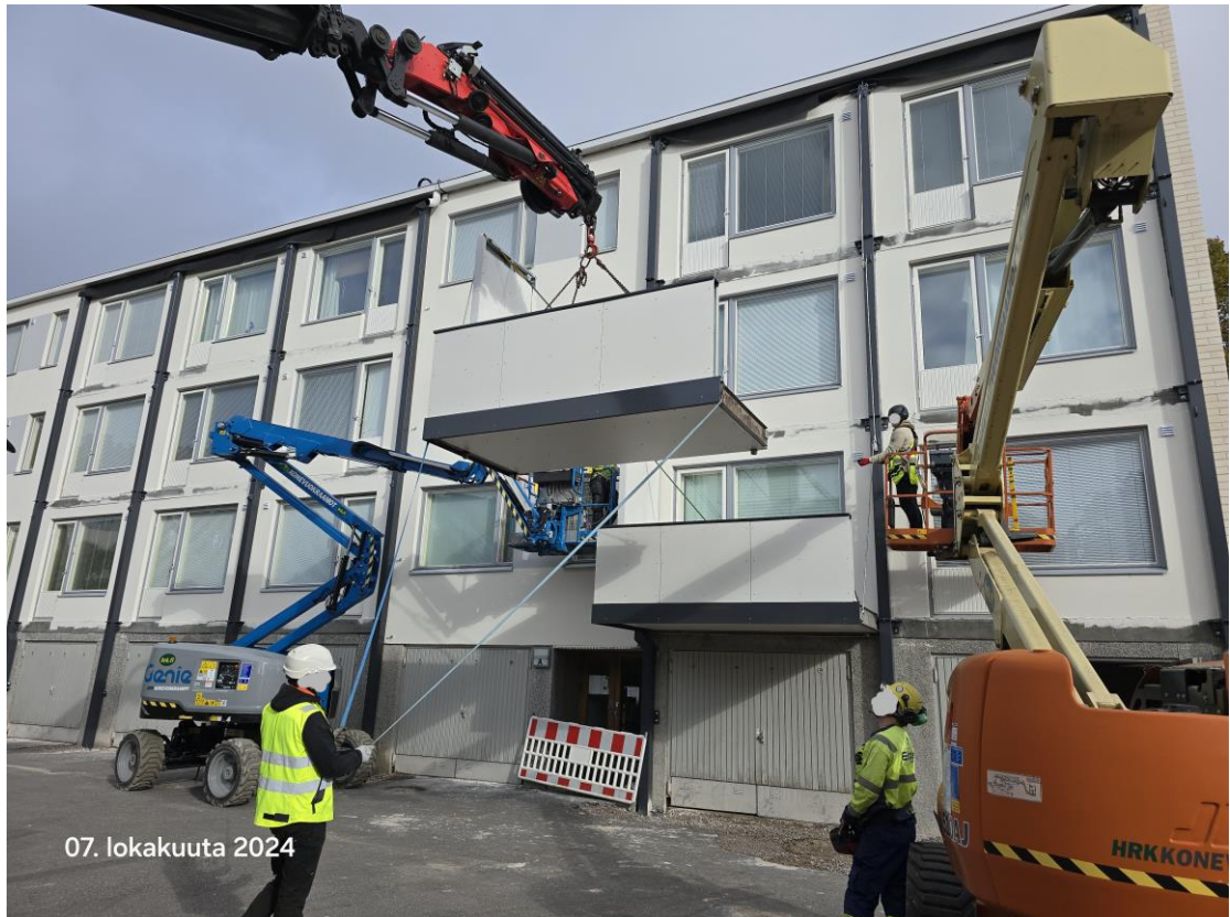
Kuva 12. Parveke-elementtiä nostetaan asennettavaksi. (Lappalainen 2024)
