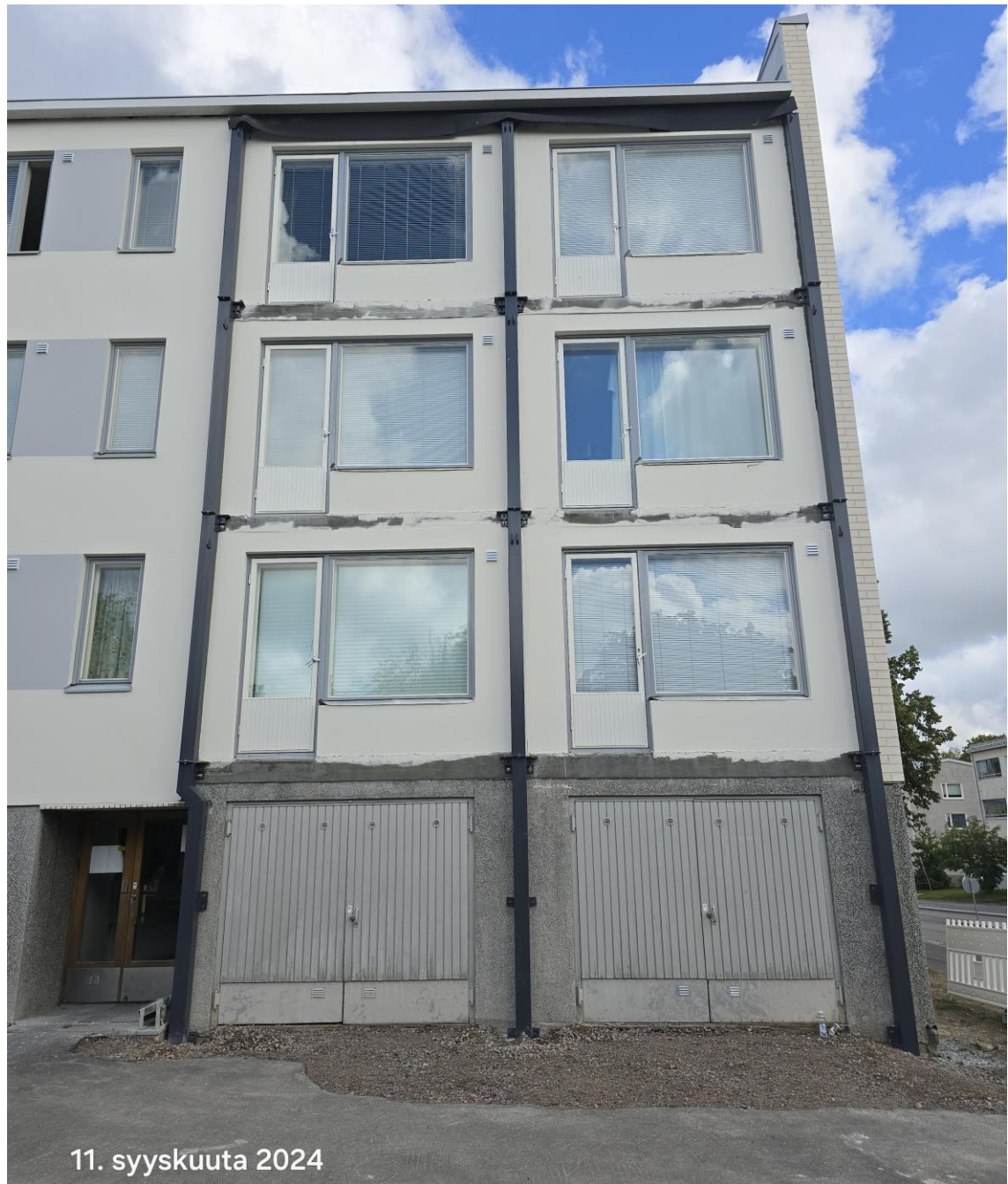
Kuva 10. Parvekelinjan pilarit asennettuna. (Lappalainen 2024)
