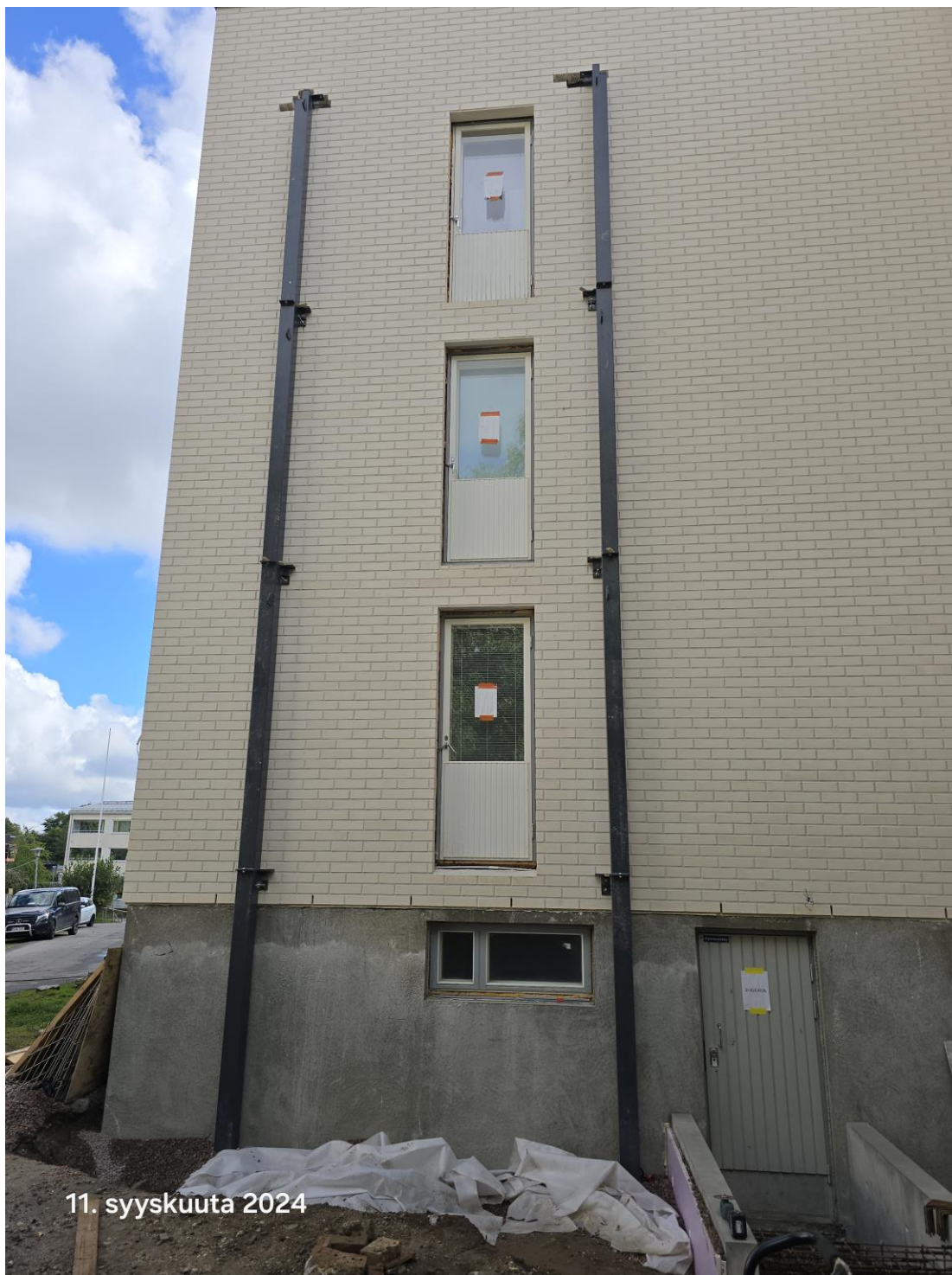
Kuva 11. Parvekepillarit julkisivumuurauksen päällä. (Lappalainen 2024)
