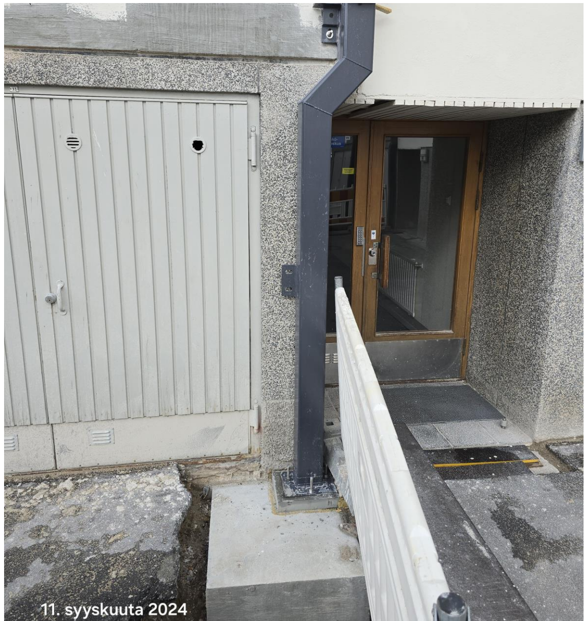
Kuva 9. Parvekepilarin perustus on tehty kallion päälle. (Lappalainen 2024)
