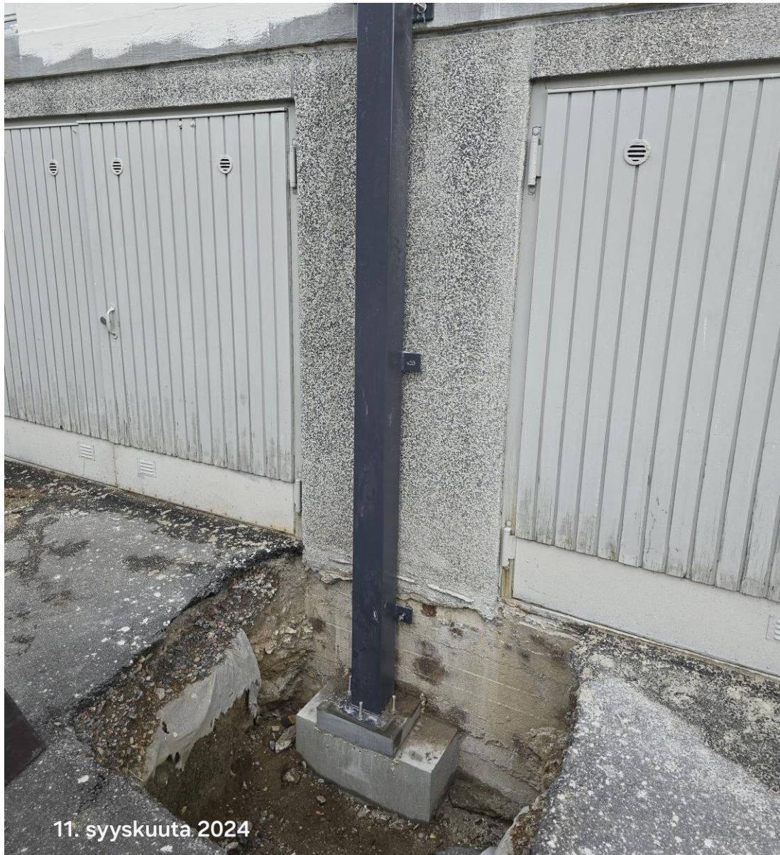
Kuva 8. Parvekepilarin perustus on tehty konsolivaluna. (Lappalainen 2024)
