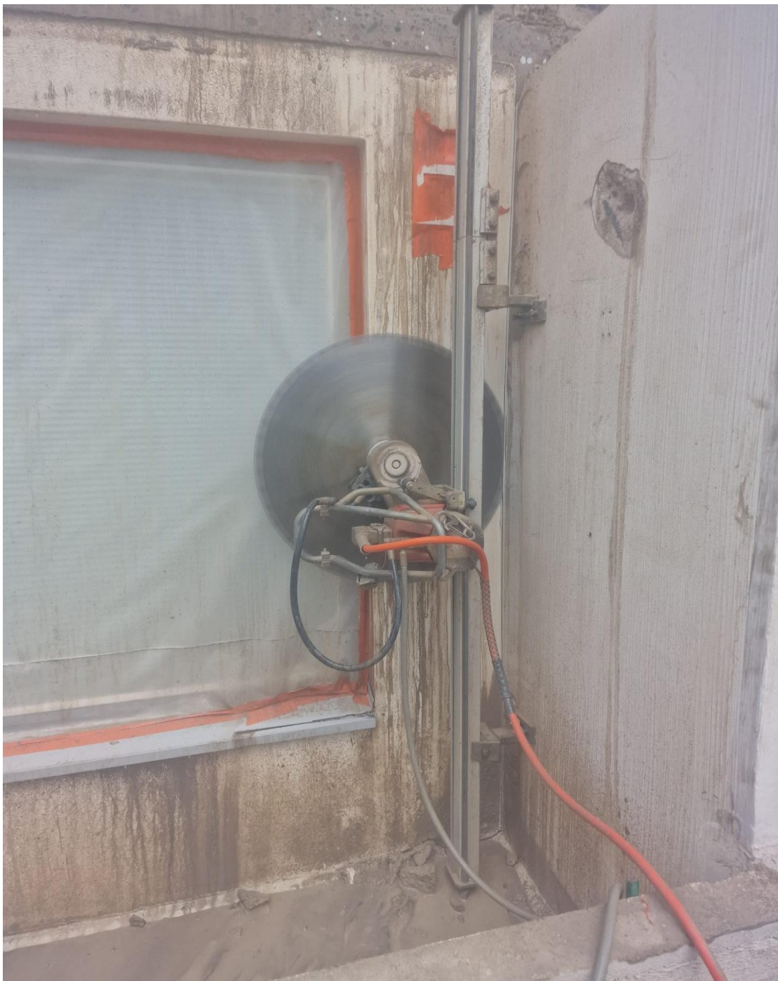
Kuva 5. Parvekeseinien purku kiskosahalla. (Lappalainen 2024)
