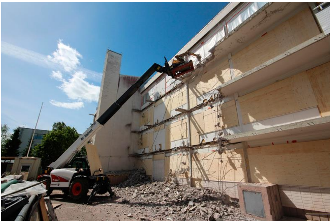
Kuva 4. Parvekkeiden purkua robottipiikkauskoneella, joka on kiinnitetty kurottajan piikkeihin. (Gles Oy)
