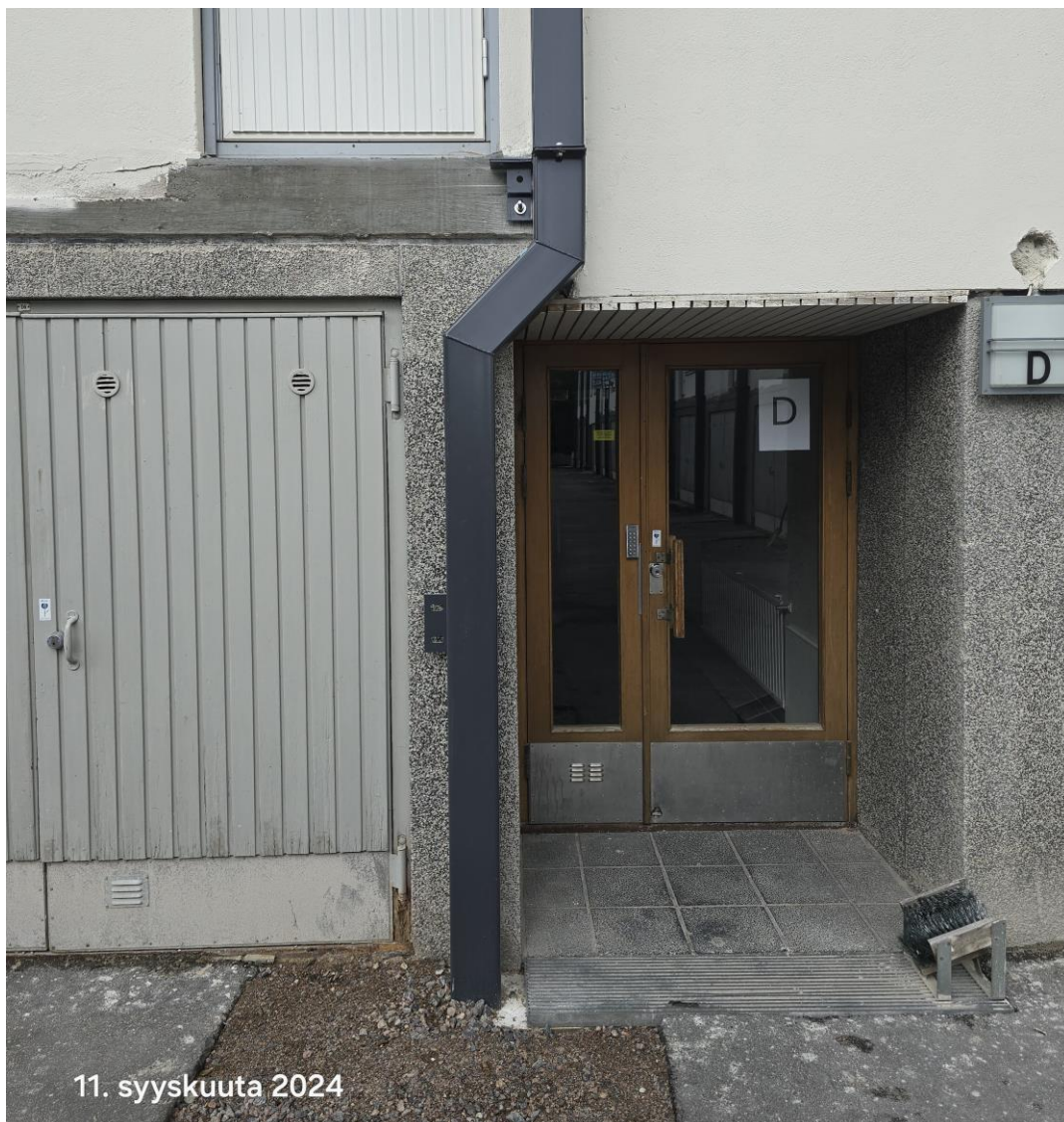
Kuva 7. Parvekepilariin on tehty mutka, jotta se on saatu pois rappukäytävän kulkuaukon edestä. (Lappalainen 2024)
