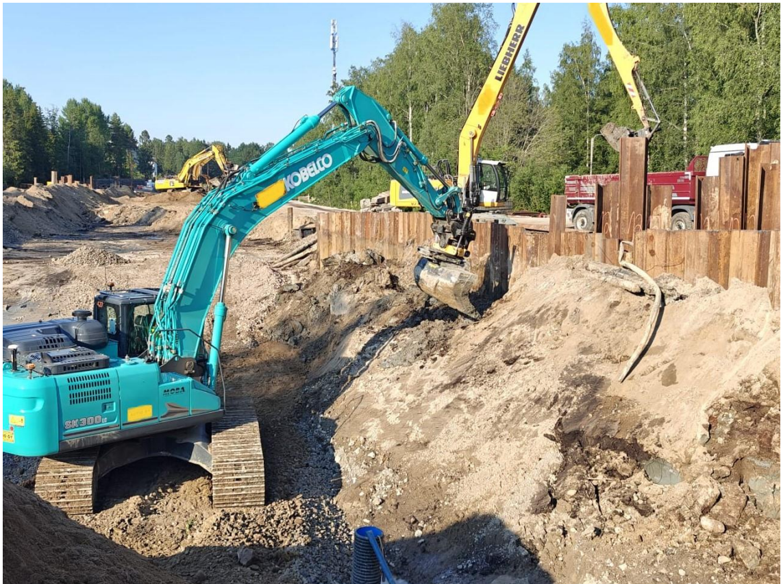
Kuva 17 Kaivinkone läjittää maat viereen, josta pitkäpuomi lastaa ne kyytiin
