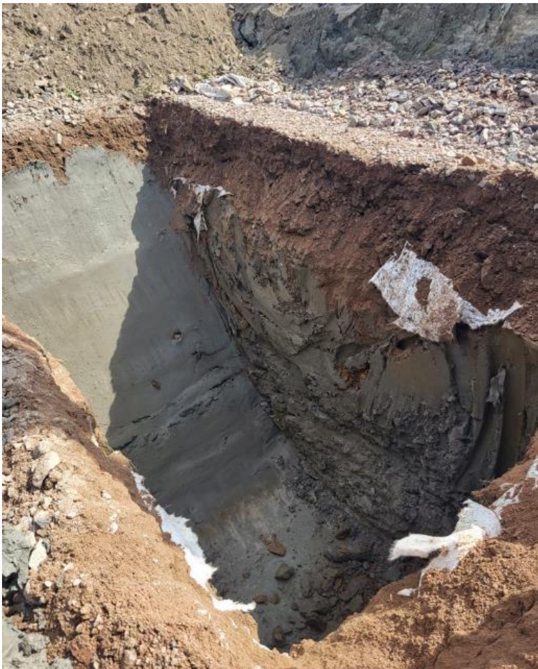
Kuva 31 Noin metrin verran mallin alta kaivettuna.
