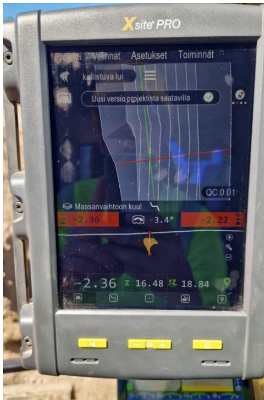
Kuva 32 Koneen ottama tarke, jossa kaivuut menevät 2,3 m alle mallin (Nime- tön kaivinkone kuski 2024).
