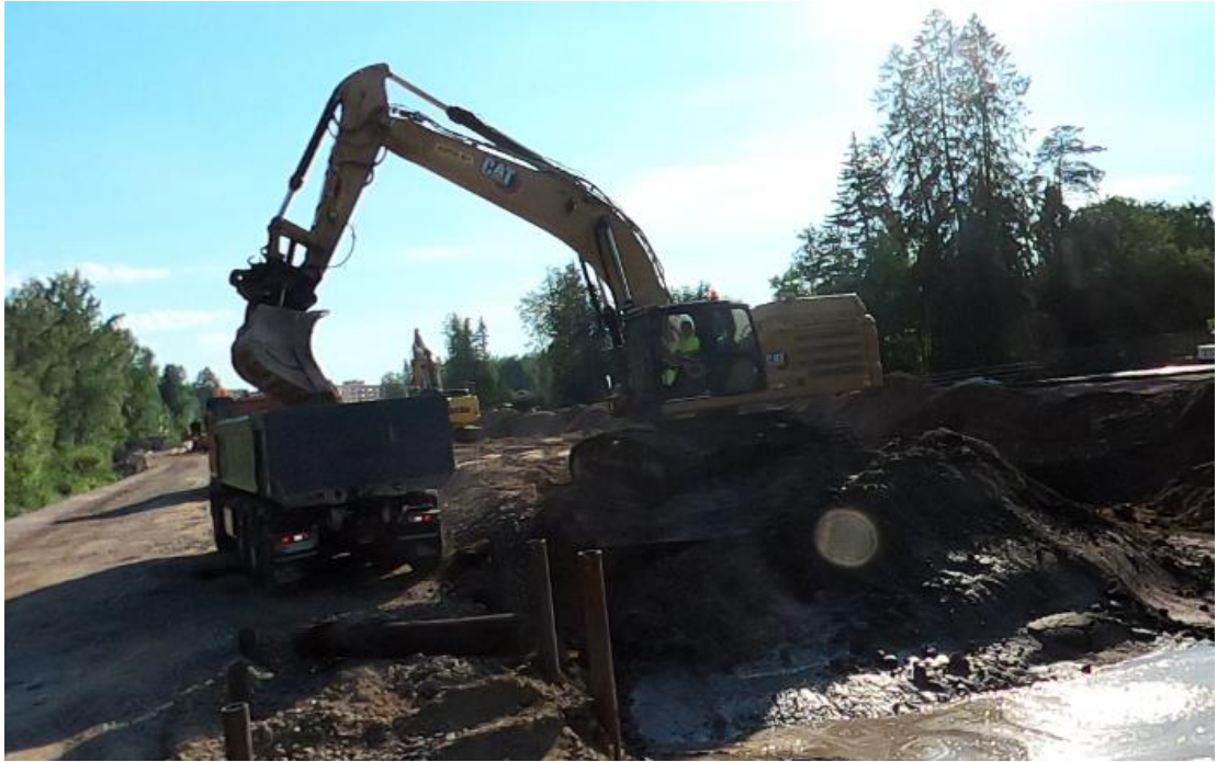
Kuva 16 50 tn kaivinkone tekemässä kaivuita.
