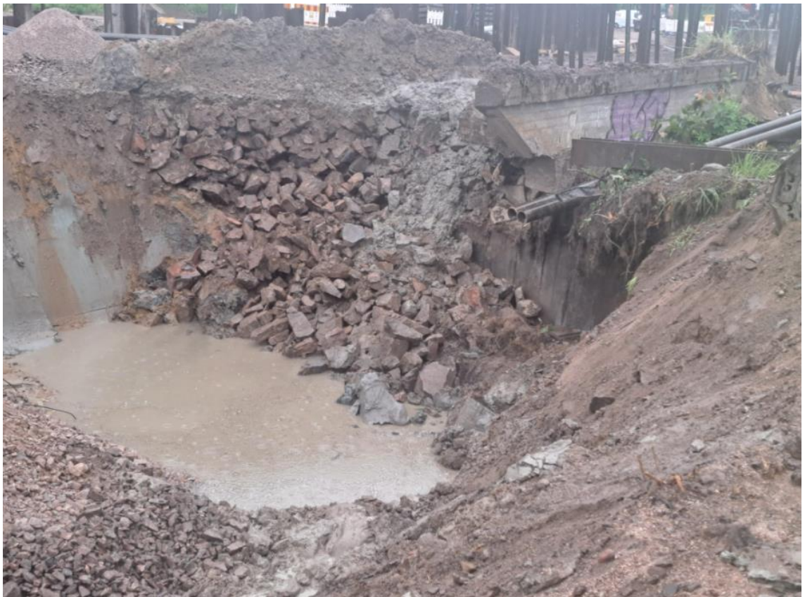
Kuva 24 Rakenteista vastaan tullutta louhetta (Vanhala 2024)
