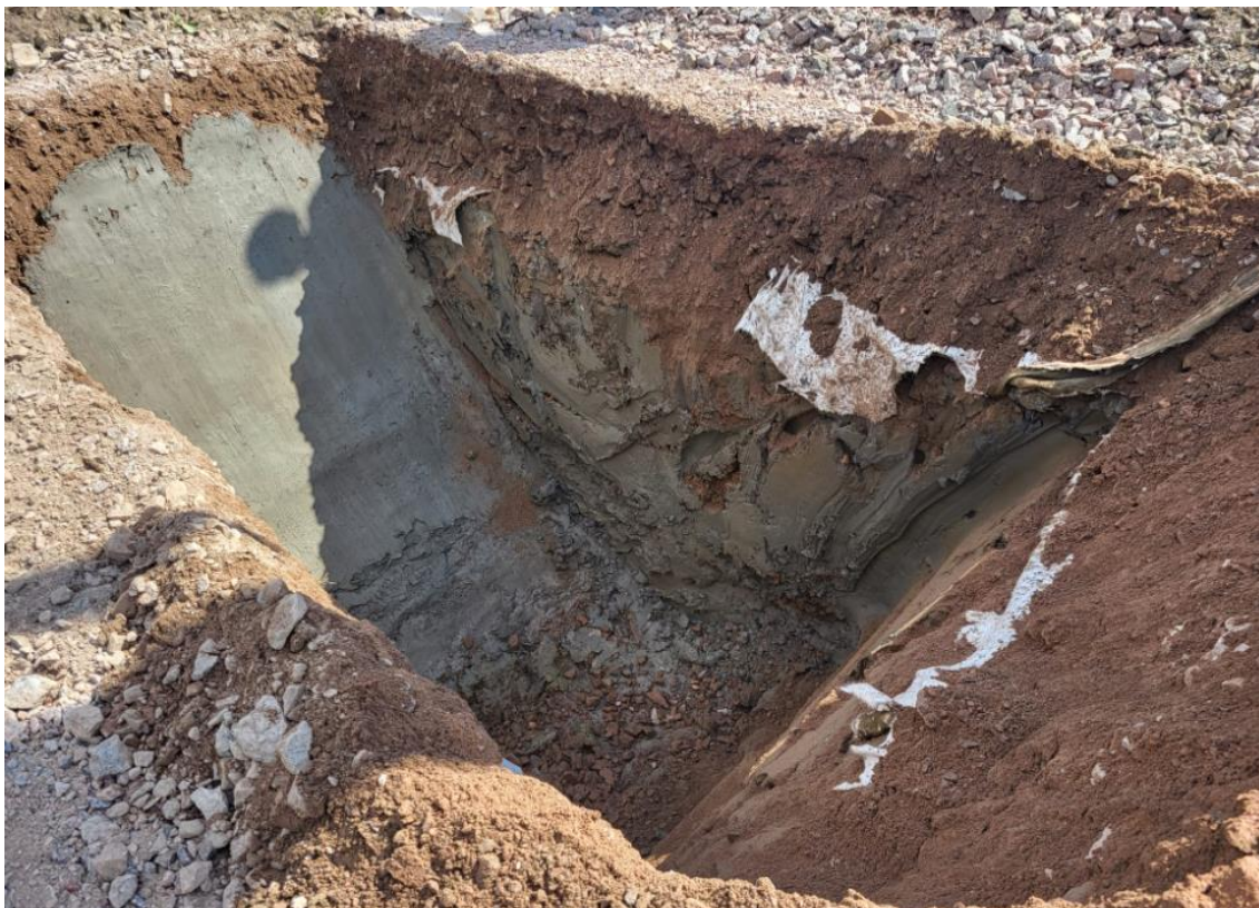
Kuva 30 Massanvaihdon mallin mukaan tehty kaivuu, jossa edelleen savea rakenteissa.
