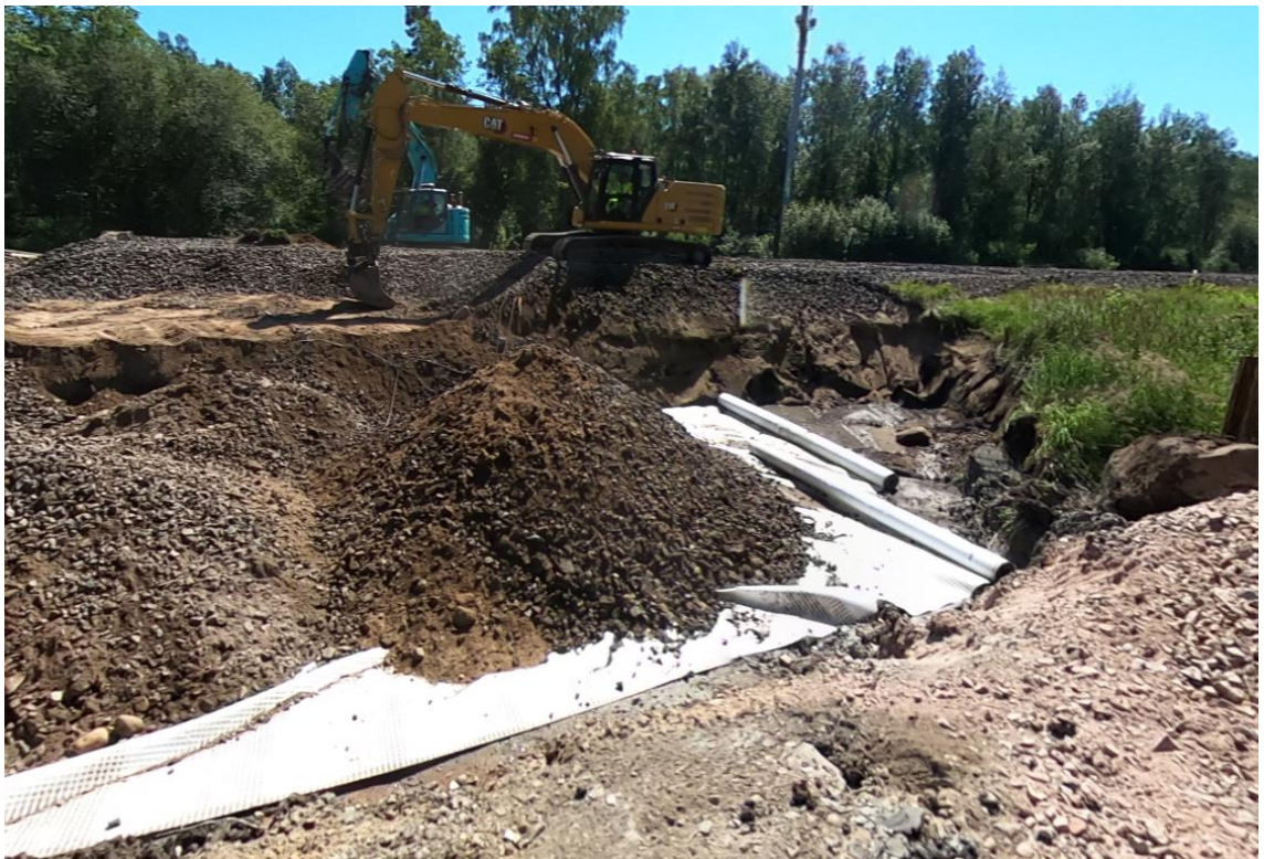
Kuva 23 Uuden radan kohdalle tehty massanvaihtoa ja vanhan radan rakenteet edelleen nähtävissä.
