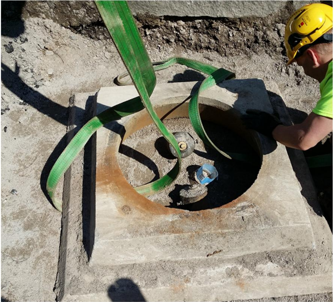
Kuva 7: Maaventiilikaivon tukirenkään asennus.
