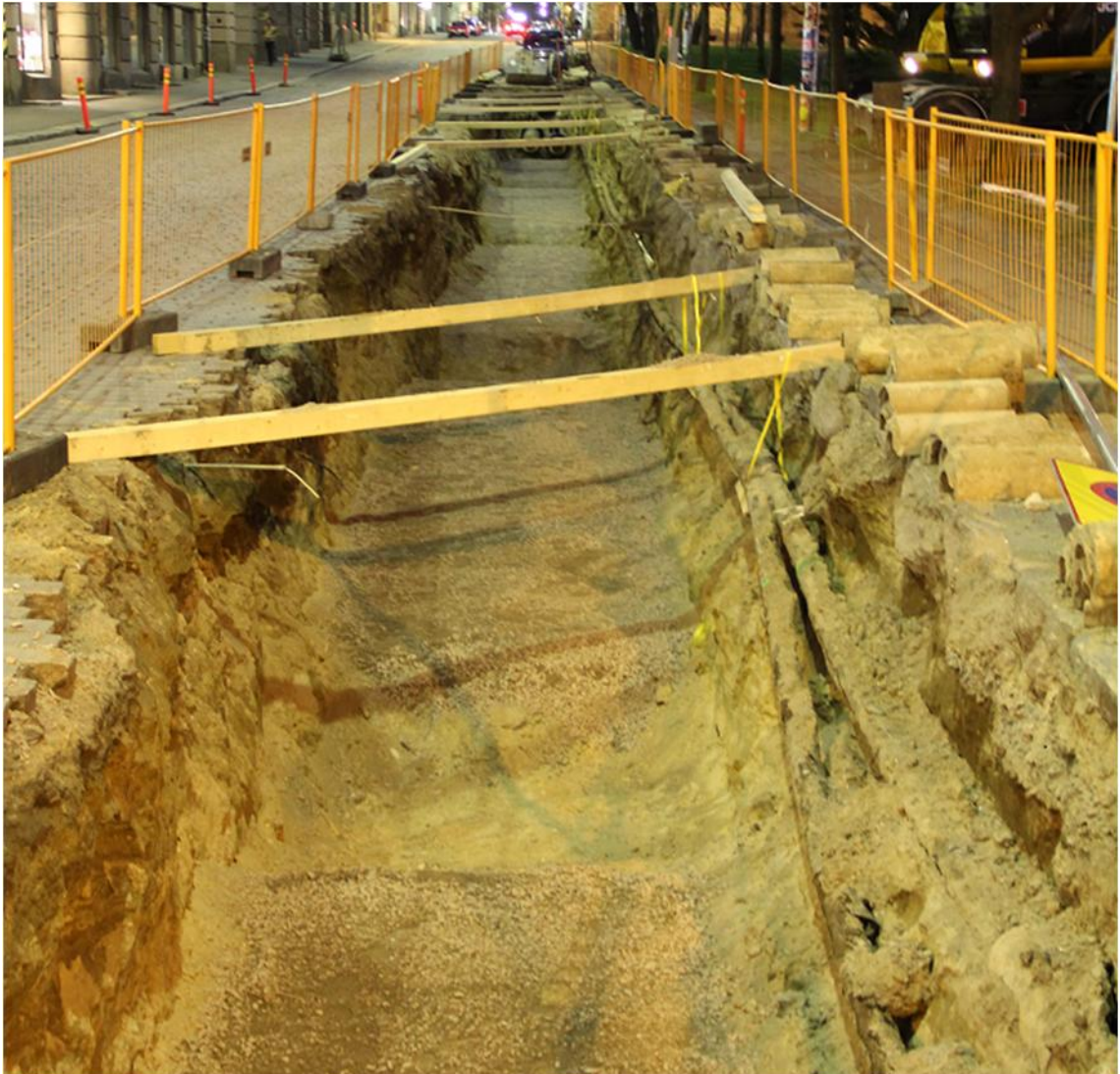
Kuva 6: Kaapelien tuentaa ja valmista asennuspohjaa kaukolämpökaivannossa.
