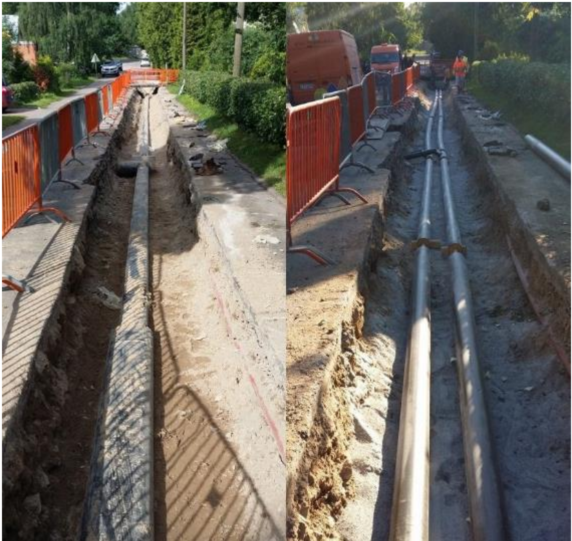
Kuva 5: Mpuk-elementtijohto uusittu 2Mpuk-johdoksi.
