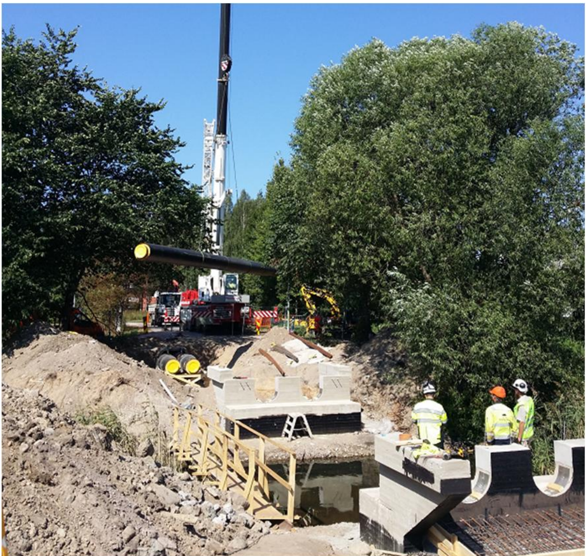
Kuva 8: Putkielementin nostotyö Mätäjellä Kannelmäessä.
