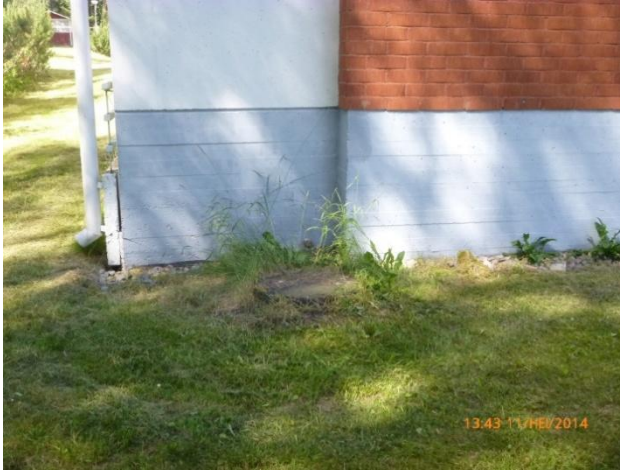
Kuva 6. Eteläpäädyn tarkastuskaivo(Petri Ahonen)
