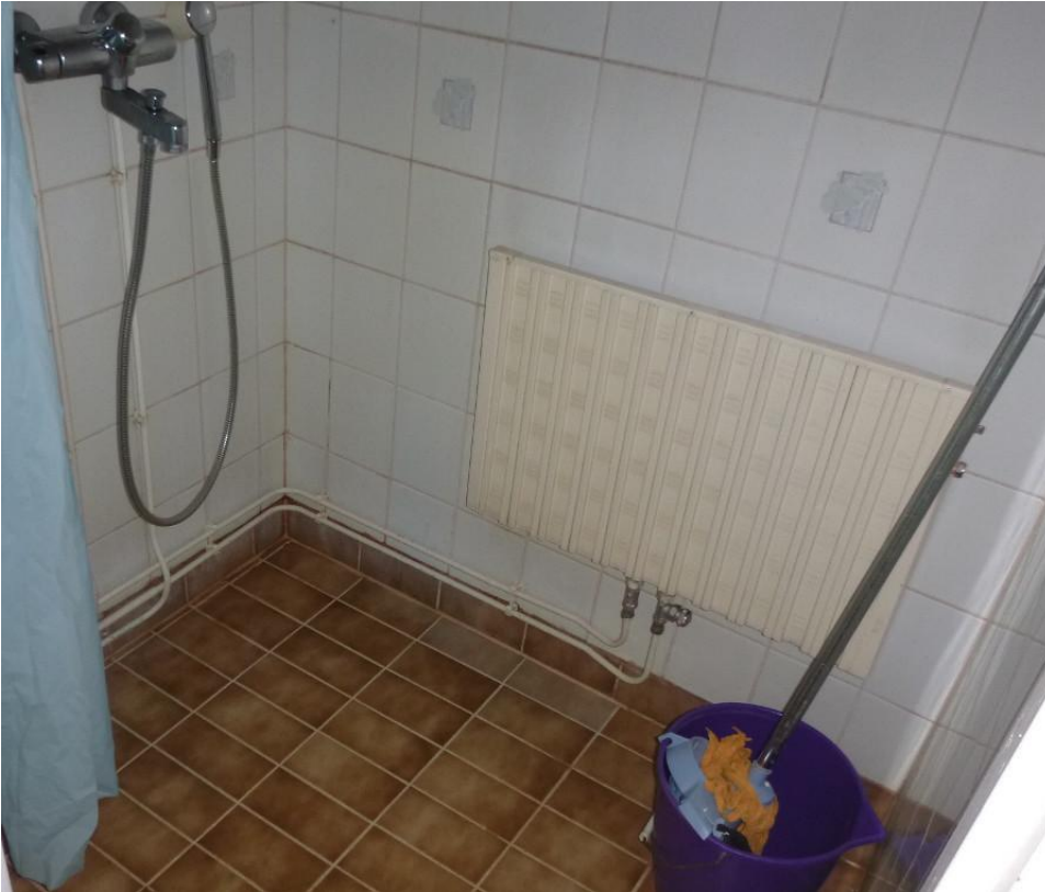
Kuva 43. Vanhin asunnoista tavattu lattialaatoitus. Laatoitus 80-luvulta. (Petri Ahonen)
