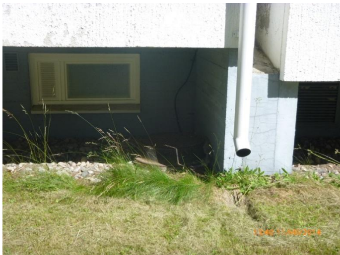
Kuva 8. Takapihan tarkastuskaivo on parvekkeen alla. (Petri Ahonen)
