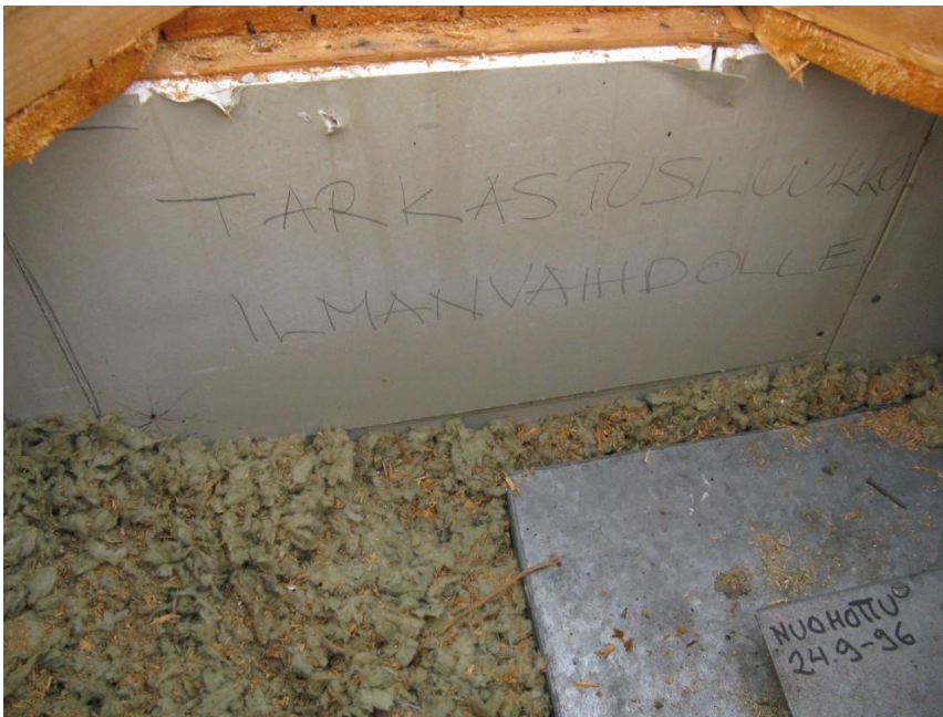
Kuva 17. Rakennuksen uudemman osan yläpohjan eristys ja vuonna -96 nuohotun iv-kanavan luukku. (Petri Ahonen)
