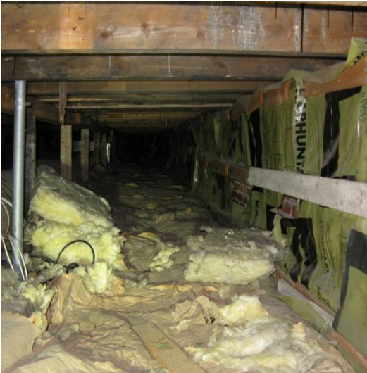
Kuva20. Vanhemman puolen yläpohjassa takapihan puolella mahtuu konttaamaan. Kulkusiltoja ei ole. (Petri Ahonen)
